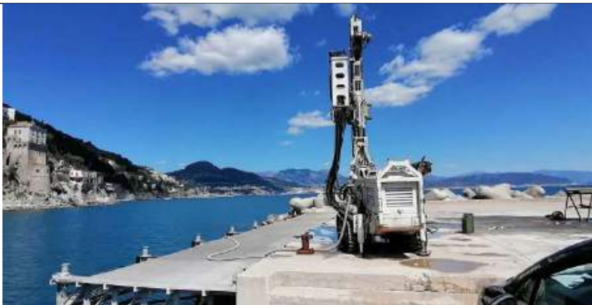
Foto 2 – Postazione perforazione S1bis.
