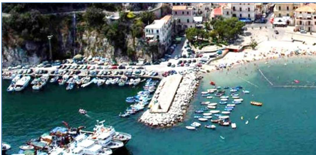
Figura 1- Preesistente sottoflutto con struttura esterna a gettata.
