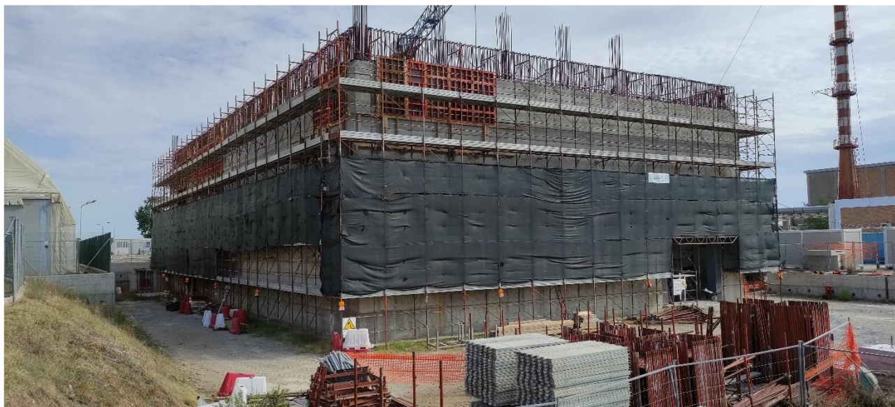
Vista dell'area del cantiere ed. Deposito DMC3/DTC3
