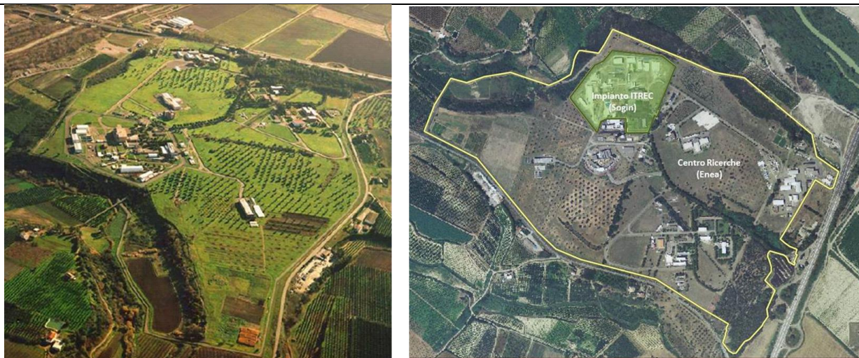
Vista aerea del CR Enea della Trisaia e del Sito ITREC
