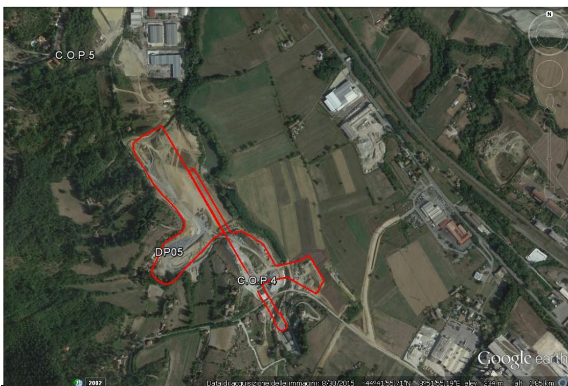
Figura 17 – Inquadramento Aerofotogrammetrico COP5/DP050
