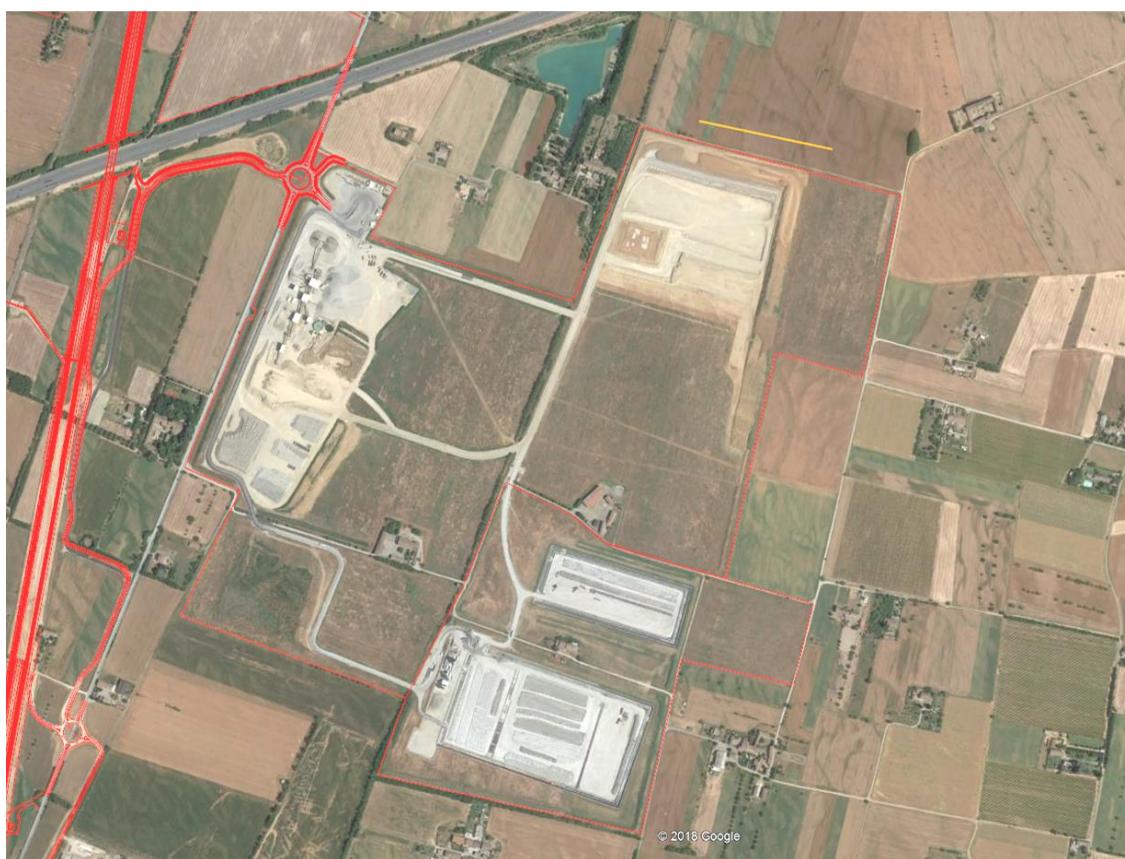
Figura 37 – Inquadrimento Aerofotogrammetrico area di cantiere
