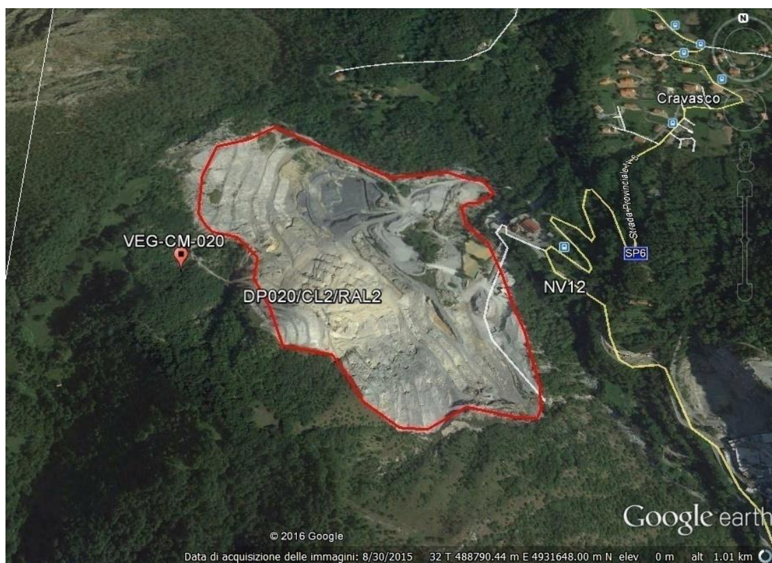
Figura 24: localizzazione stazione di rilievo VEG-CM-020
