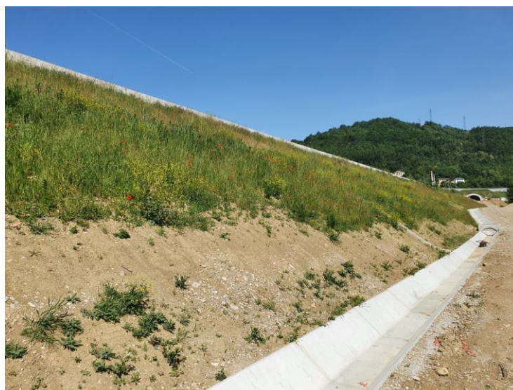
Figura 89: area di cantiere VEG-SS-500D
