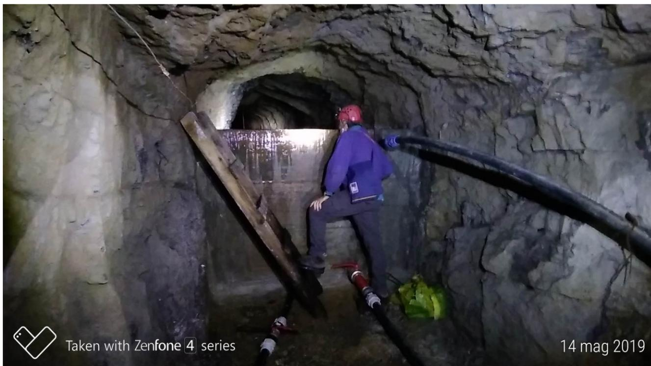
*Figura 112- Ripresa fotografica della diramazione laterale di livello Ponente prossima al Torrente con il manufatto di presa per la derivazione di acqua.*
