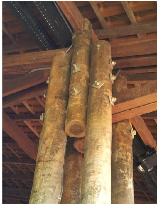
*Figura 3.9 Esempio di utilizzazione di tronchi di legno – effetto complessivo e dettaglio costruttivo (utilizzazione in un porticato del centro visitatori di un Parco)*
