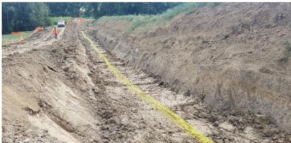
A conclusione delle operazioni di rinterro, si provvederà a ridistribuire sulla superficie il terreno vegetale accantonato in precedenza (si veda Figura 2-17).
