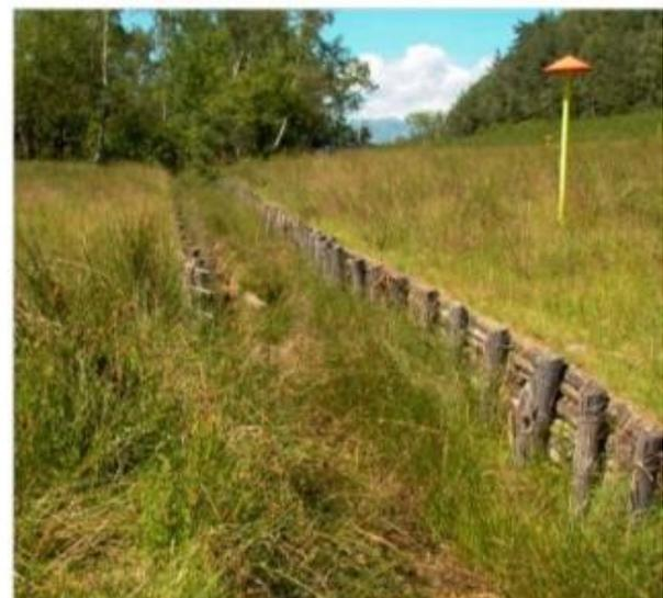
Lungo i versanti a maggiore acclività, oltre alle opere sopra descritte, soprattutto in corrispondenza di pendii particolarmente lunghi, all'interno della trincea dello scavo, potranno essere realizzate strutture di contenimento rompitratta. Si tratta di diaframmi in
