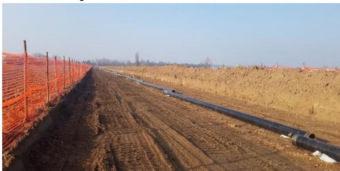
Figura 9-5 – Sfilamento delle tubazioni di linea
