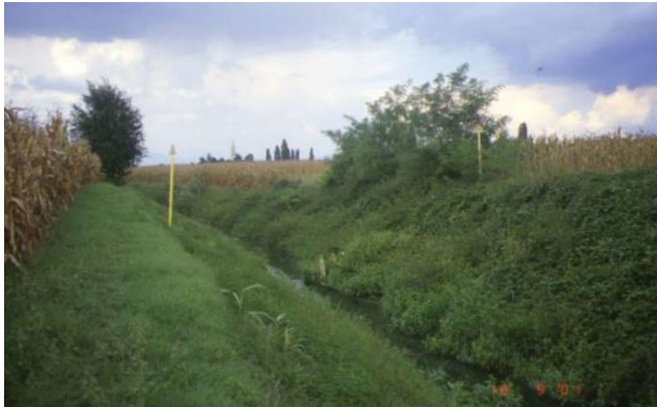
Figura 9-23 – Esempio di opera ultimata in corrispondenza di attraversamento di corso d'acqua in ambito agricolo
