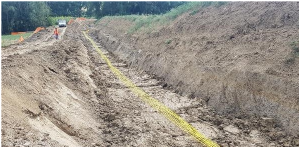
Figura 9-11 – Rinterro della condotta
