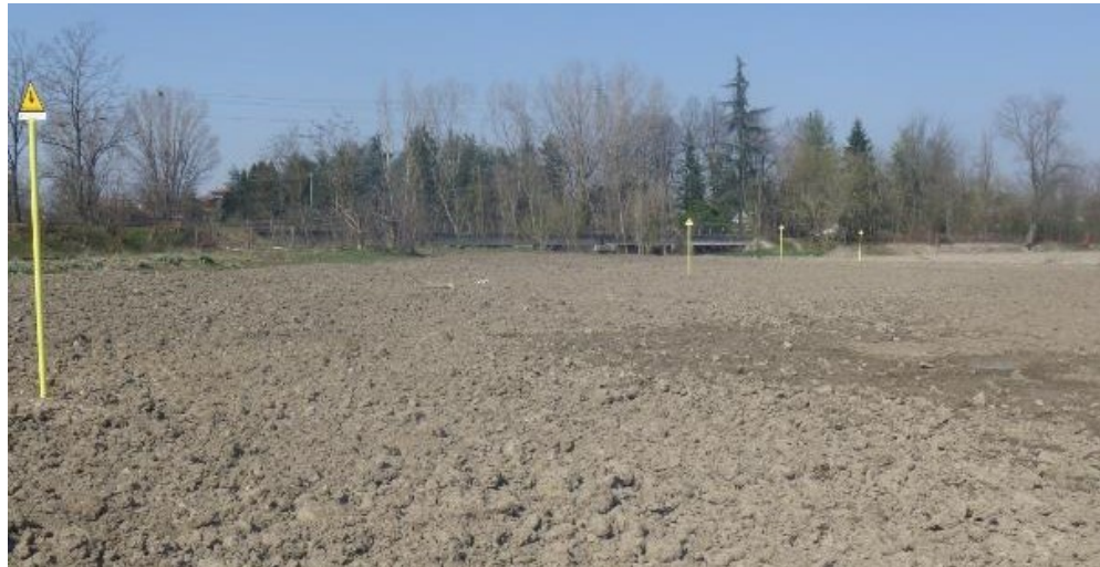
Figura 9-21 – Pista lavori, su terreno agricolo, a ripristini ultimati; si nota la disposizione delle paline segnaletiche su metanodotto in esercizio
