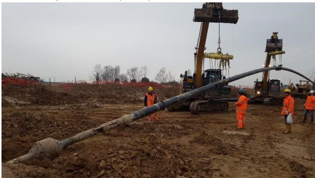
Figura 9-19 – Esempio di operazione di varo della TOC
