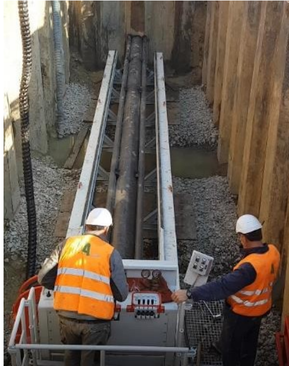
Figura 9-15 – Esecuzione di trivellazione spingitubo
