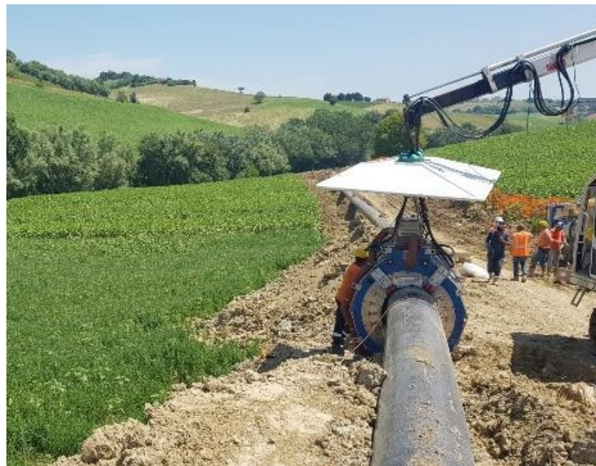
Figura 9-7 – Esempio di saldatura automatica
