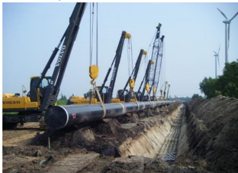
Figura 9-10 – Posa della condotta
