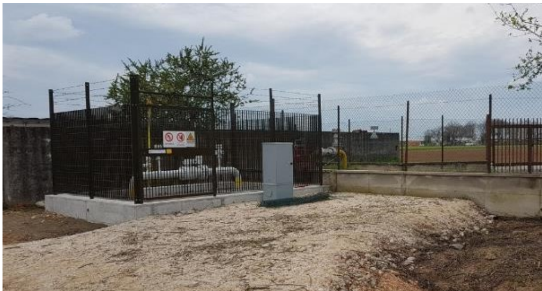
Figura 9-20 – Esempio di punto di linea al termine dei lavori
