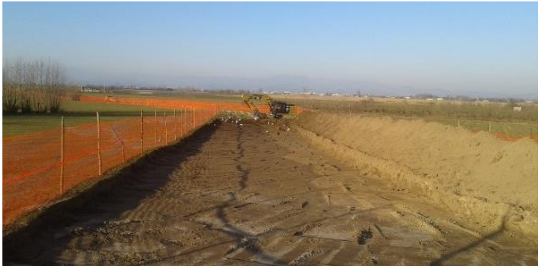
Figura 9-1 – Foto di apertura della pista di lavoro
