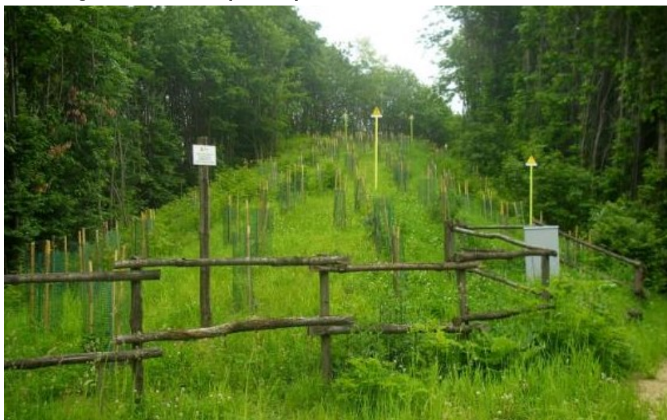
Figura 9-22 – Esempio di opera ultimata in ambito boscato
