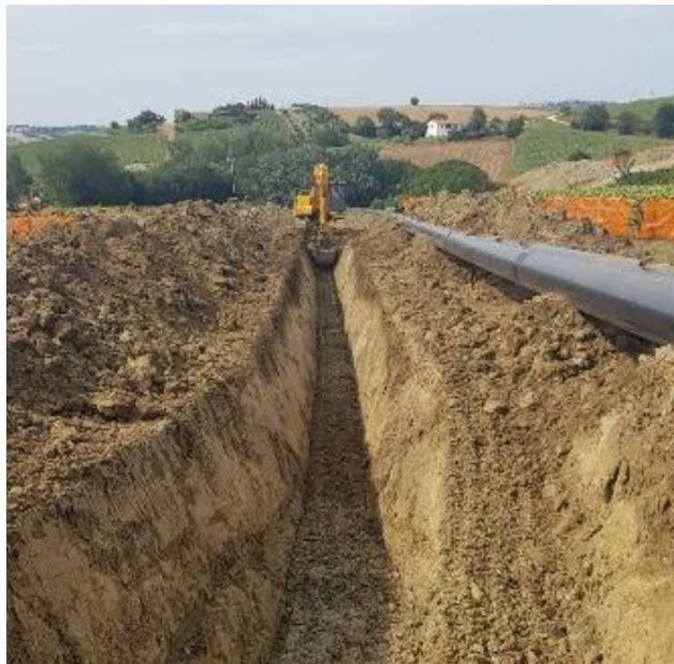
Figura 9-8 – Scavo della trincea
