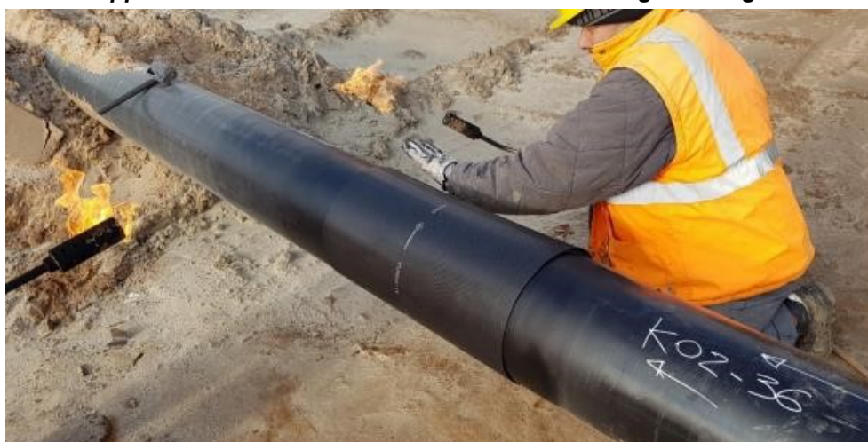
Figura 9-9 – Applicazione manuale di una fascia termorestringente su giunto saldatura
