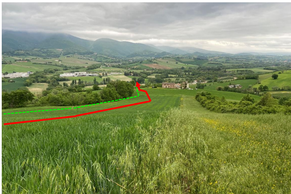
Foto n.62 – panoramica metanodotto in progetto (vista senso gas)
