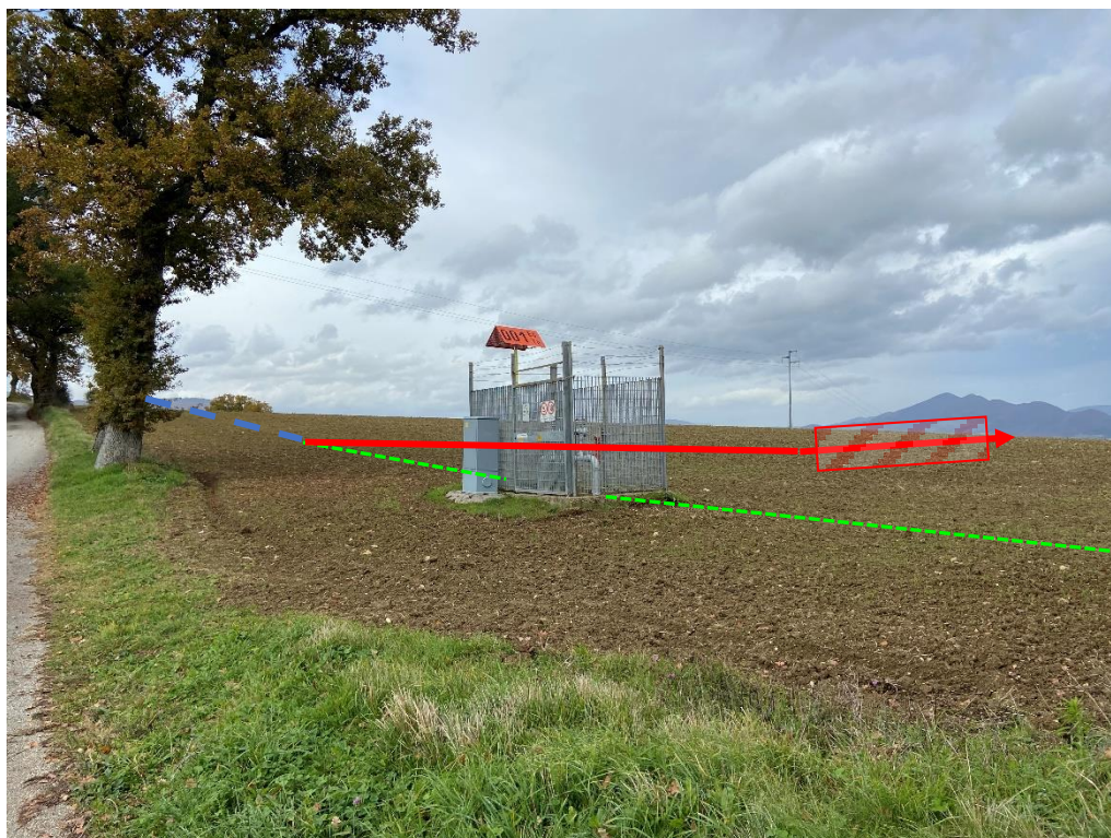
Foto n.24 – Tee-in metanodotto in progetto e impianto PIDS 4105052/1 da rimuovere
