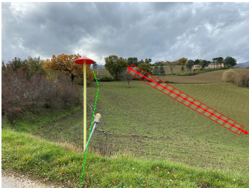
Foto n.26 – attraversamento versante in trenchless
