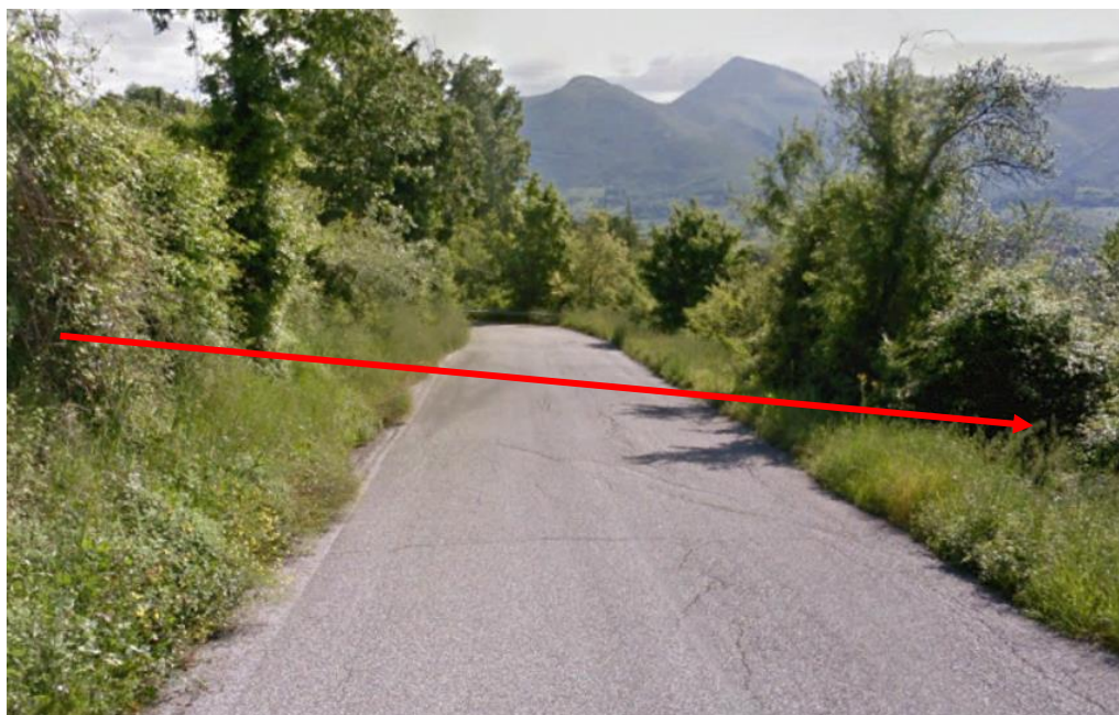
Foto n.56 – attraversamento S.P. n. 46
