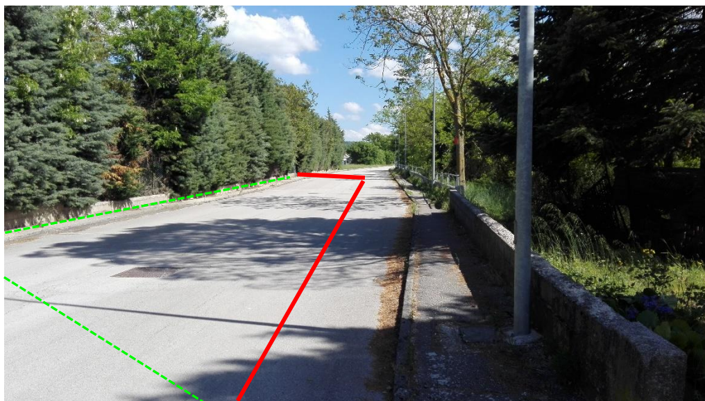
Foto n.43 – percorrenza sotto strada del metanodotto “ Allacciamento Comune di Matelica 2^presa DN 150(6”), DP 75 bar” (vista contro senso gas)
