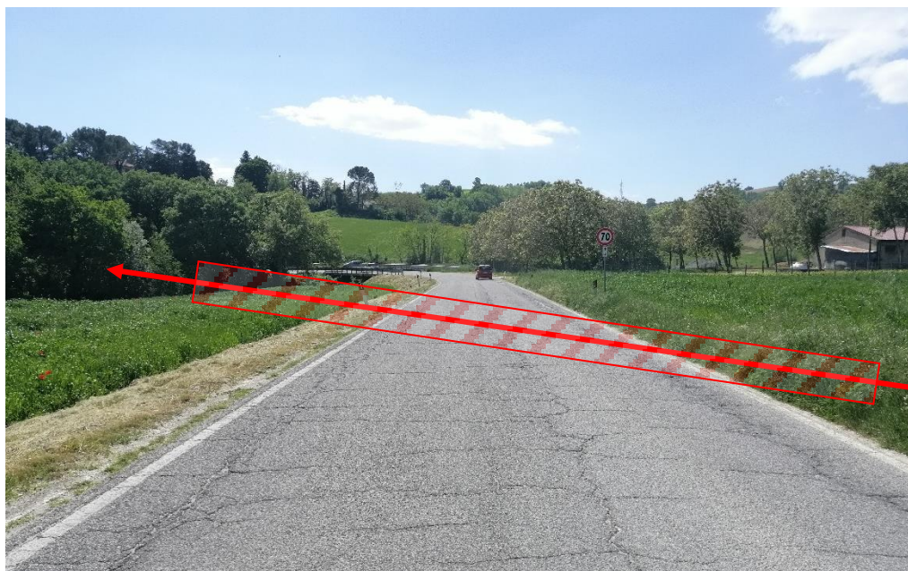
Foto n.14 – Attraversamento S.P. n.71
