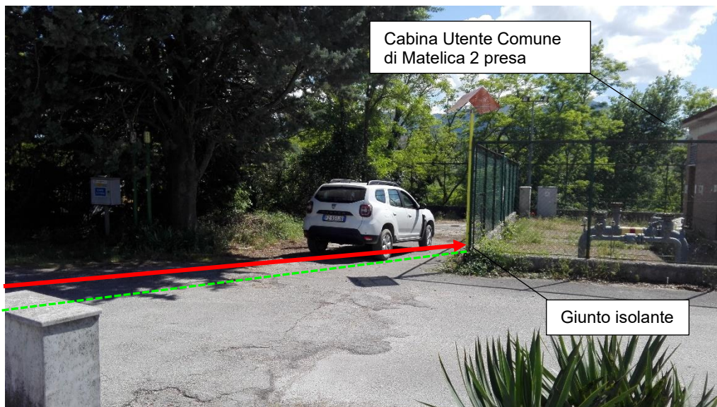
Foto n.44 – ricollegamento a cabina utente Comune di Matelica 2 presa
