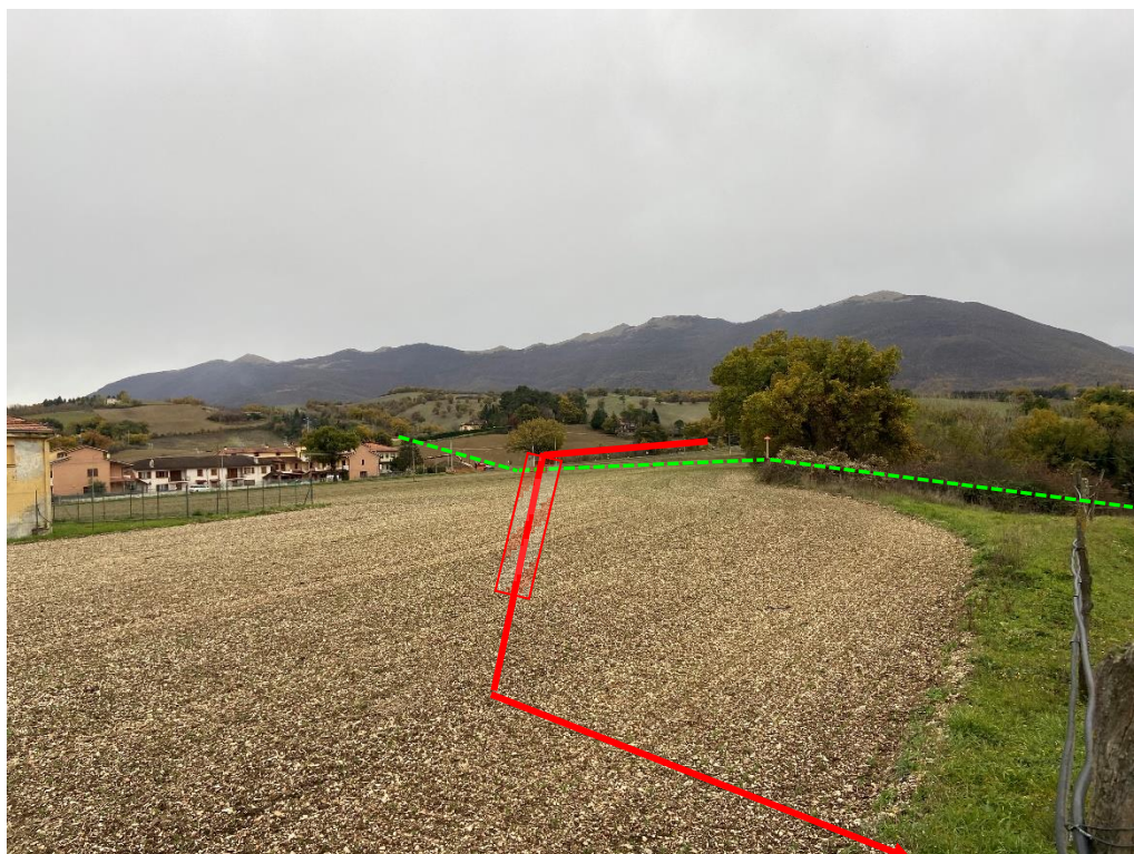
Foto n.19 – Punto ingresso seconda opera trenchless Trenchless
