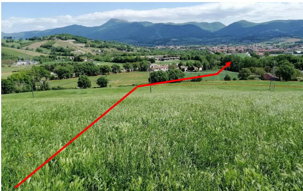
Foto n.13 – panoramica metanodotto in progetto (vista senso gas)
