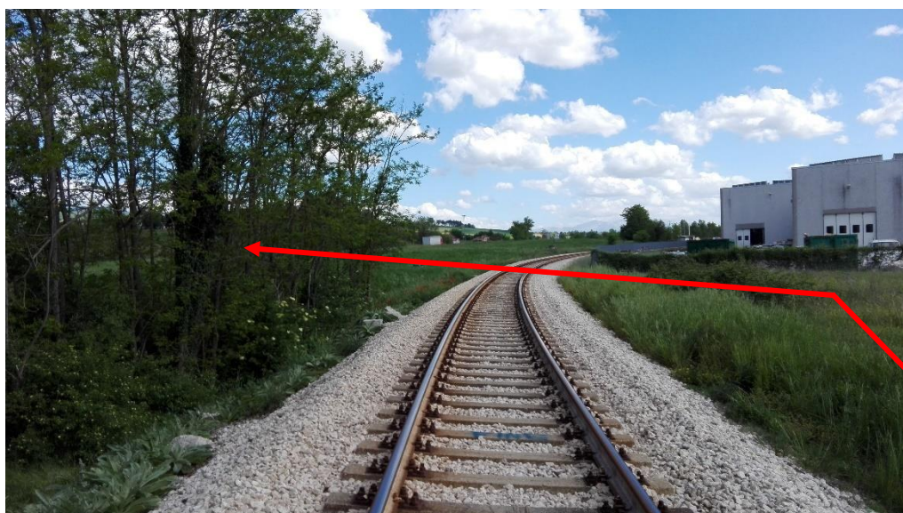
Foto n.73 – Attraversamento Ferrovia Civitanova-Albacina
