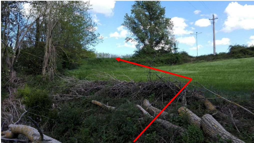
Foto n.70 – Attraversamento fosso Fogliano a cielo aperto (vista senso gas)
