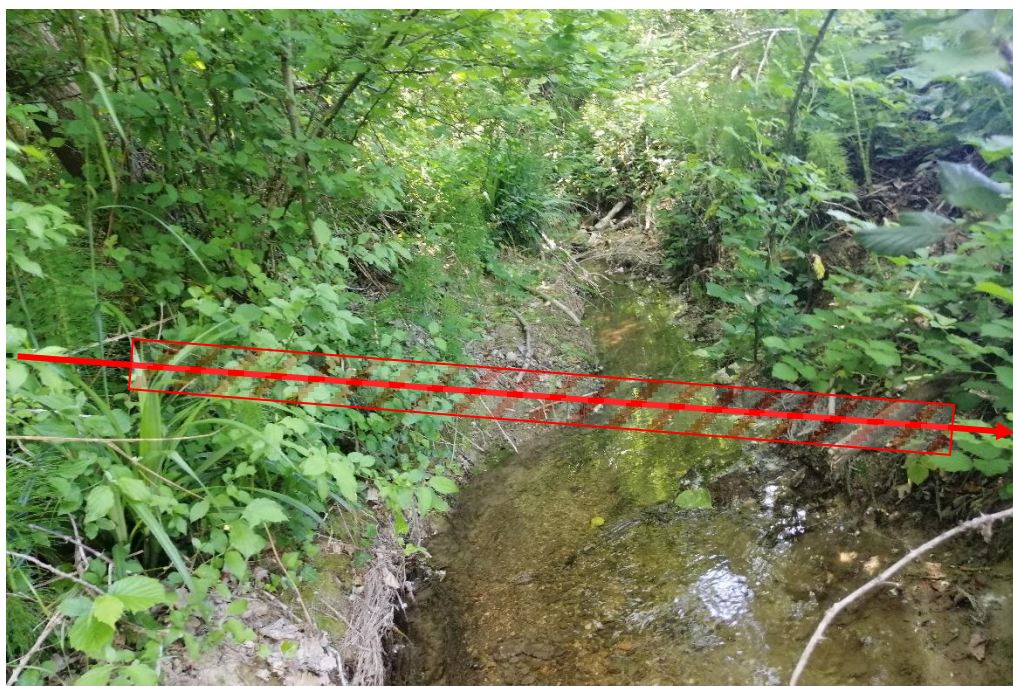
Foto n.15 – Attraversamento Fosso in Trenchless
