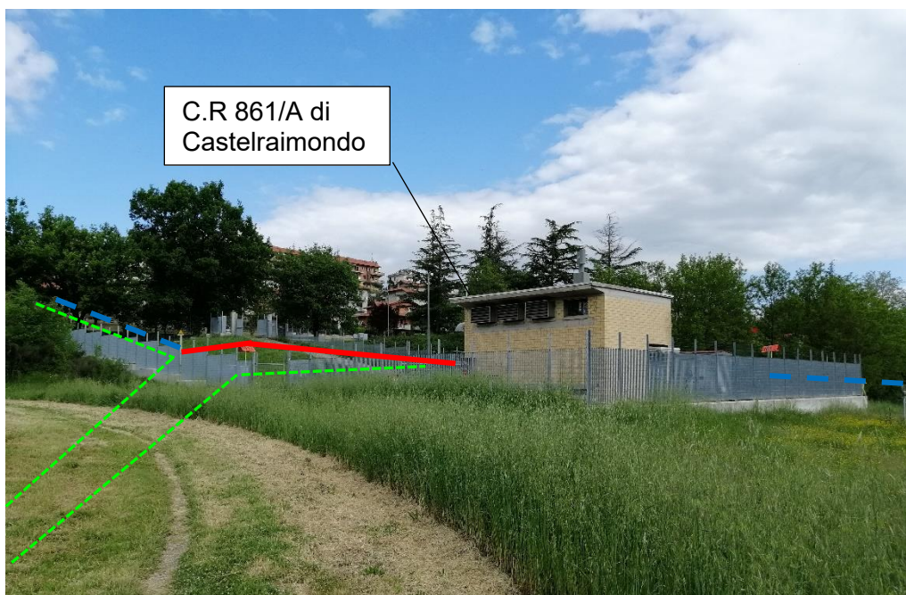
Foto n.5 – C.R. 861/A di Castelraimondo da rimuovere
