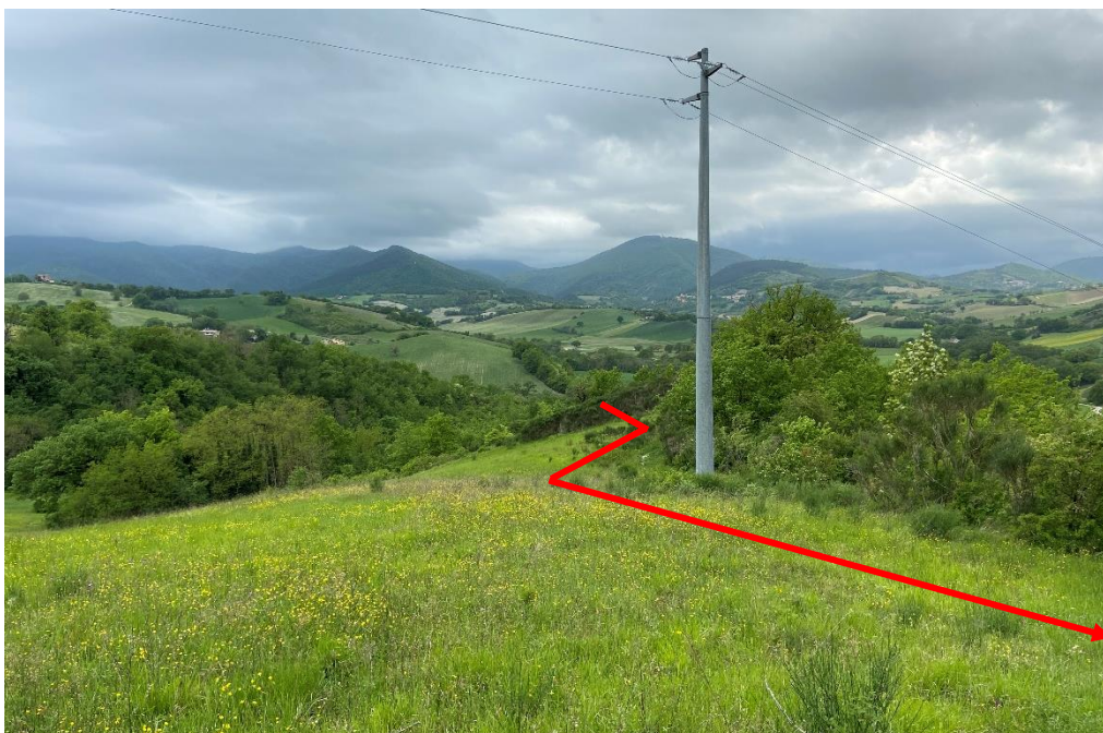
Foto n.50 – risalita in cresta a versante (allargamento per evitare palo elettrico MT)
