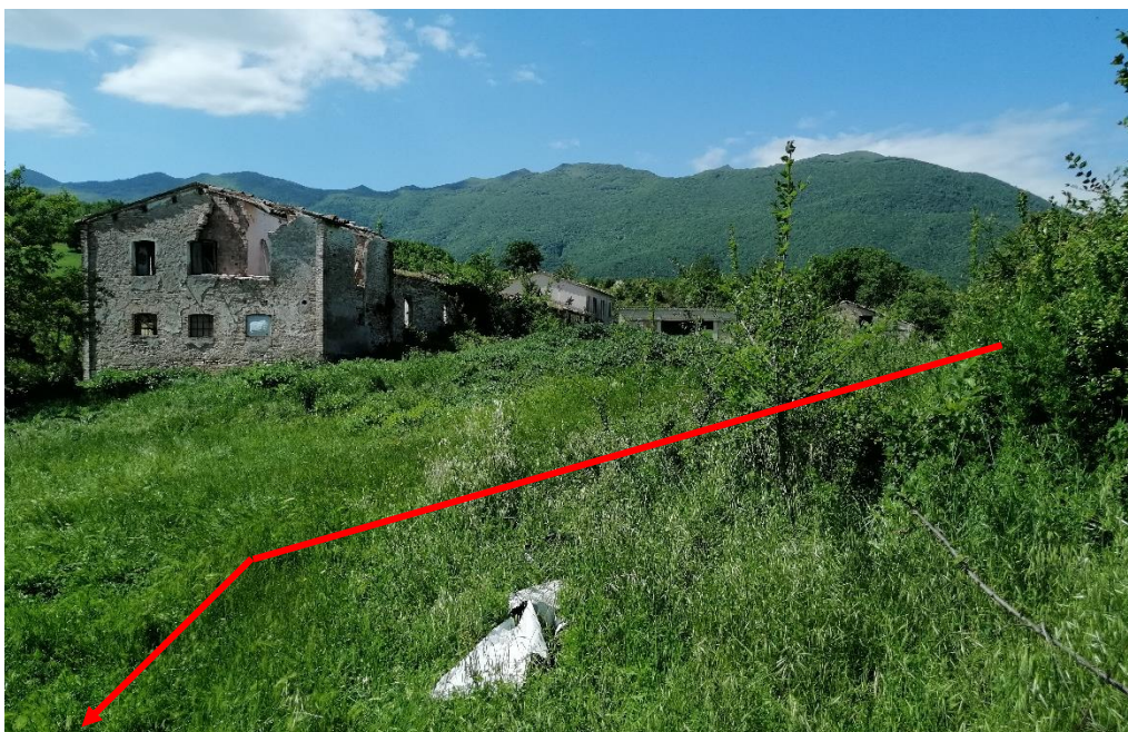
Foto n.12 – percorrenza in adiacenza a rudere (vista contro senso gas)
