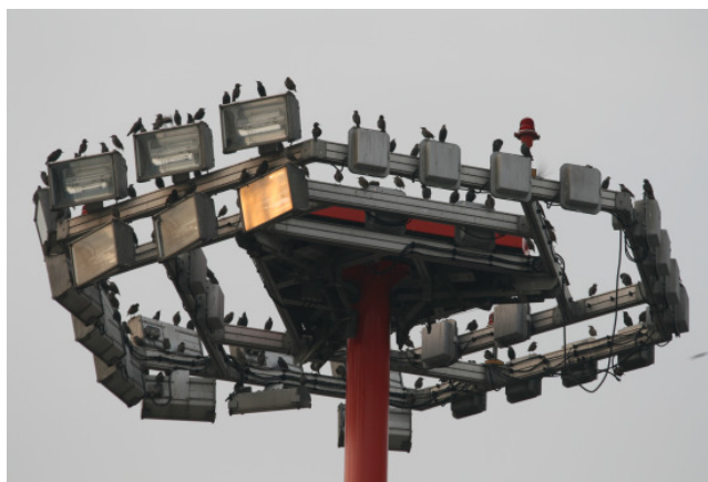
Figura 3.69: storni su una delle torri faro del piazzale
