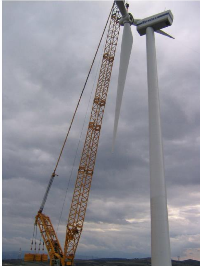
Figura 4 : Fase di montaggio dell'aerogeneratore
