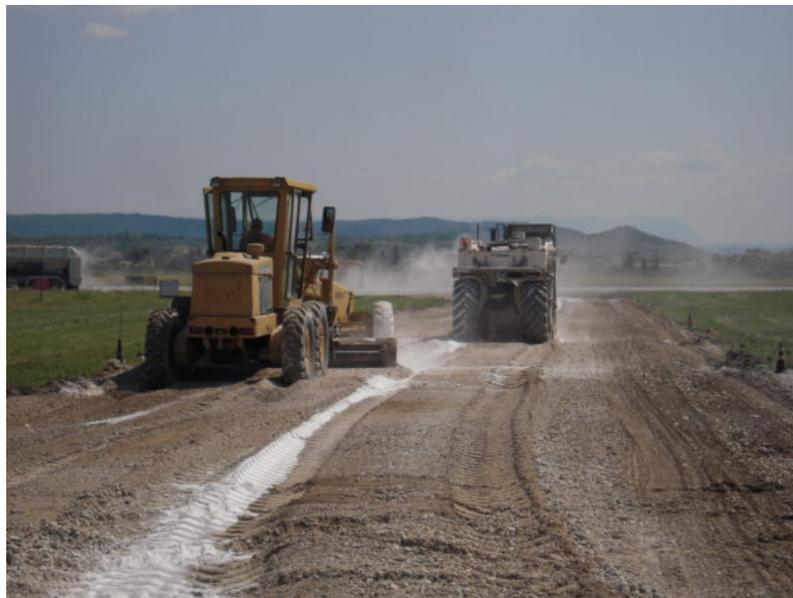
La fase successiva è quella di determinazione dell'umidità naturale della terra da trattare e, a seconda del valore trovato, la si erpicherà e la si arieggerà per favorire l'evaporazione dell'acqua, quando essa sia in forte eccesso rispetto al valore richiesto per la miscela del progetto.
