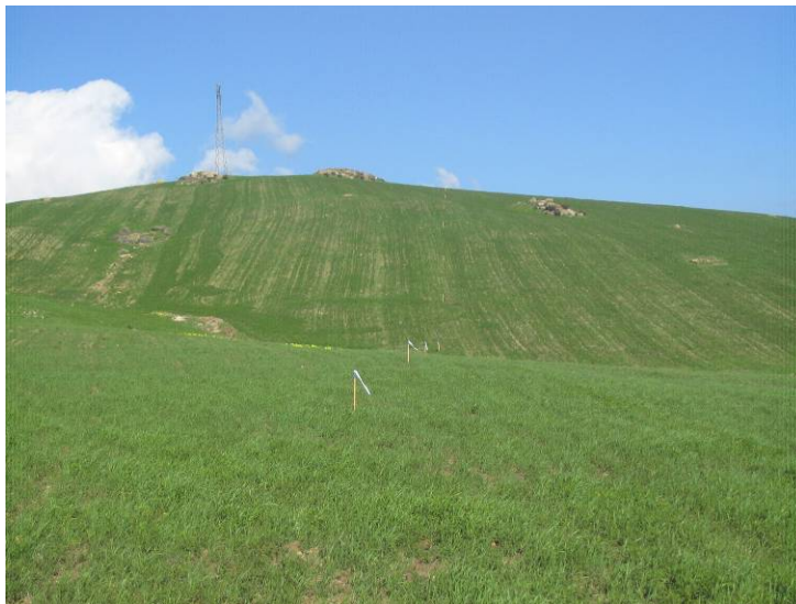
Picchettamento linea ad opera della squadra topografica
