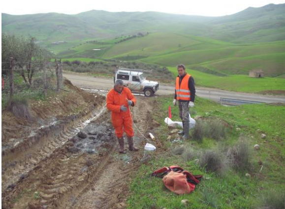
Caricamento foro da parte del fochino. A destra foro caricato in attesa del brillamento.
