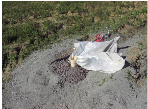
Caricamento foro da parte del fochino. A destra foro caricato in attesa del brillamento.
