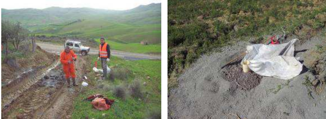
Figura 2.n: Caricamento Foro e Foro Caricato in attesa del Brillantamento
