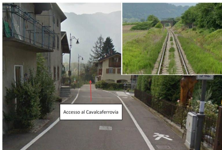
Figura 9: Stato attuale del Cavalcaferrovia alla pk 117+362
