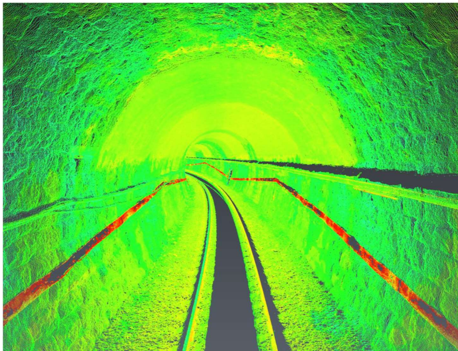
Figura 13: esempio di rilievo laser scanner della Galleria S. Rocco.
