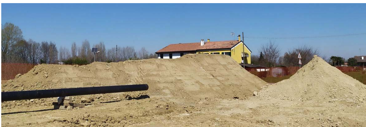
Fig. 11/b – Schemi generali di posa degli elementi fonoassorbenti: banchetta in terra battuta
