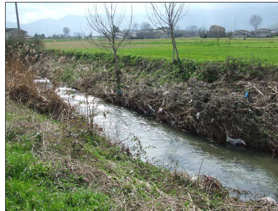
Figura 3.3: Il corso del Fossato Maggiore in corrispondenza dell'area di intervento
