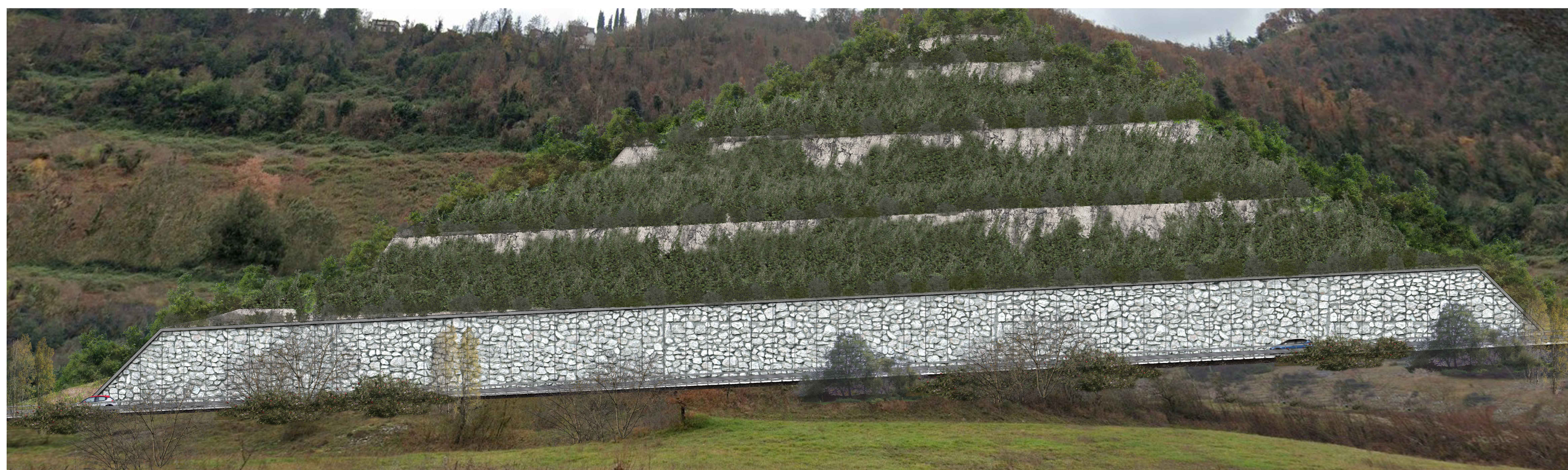
ESECUZIONE TAGLI DI VERSANTE - PROSPETTO CON FOTOSIMULAZIONE
