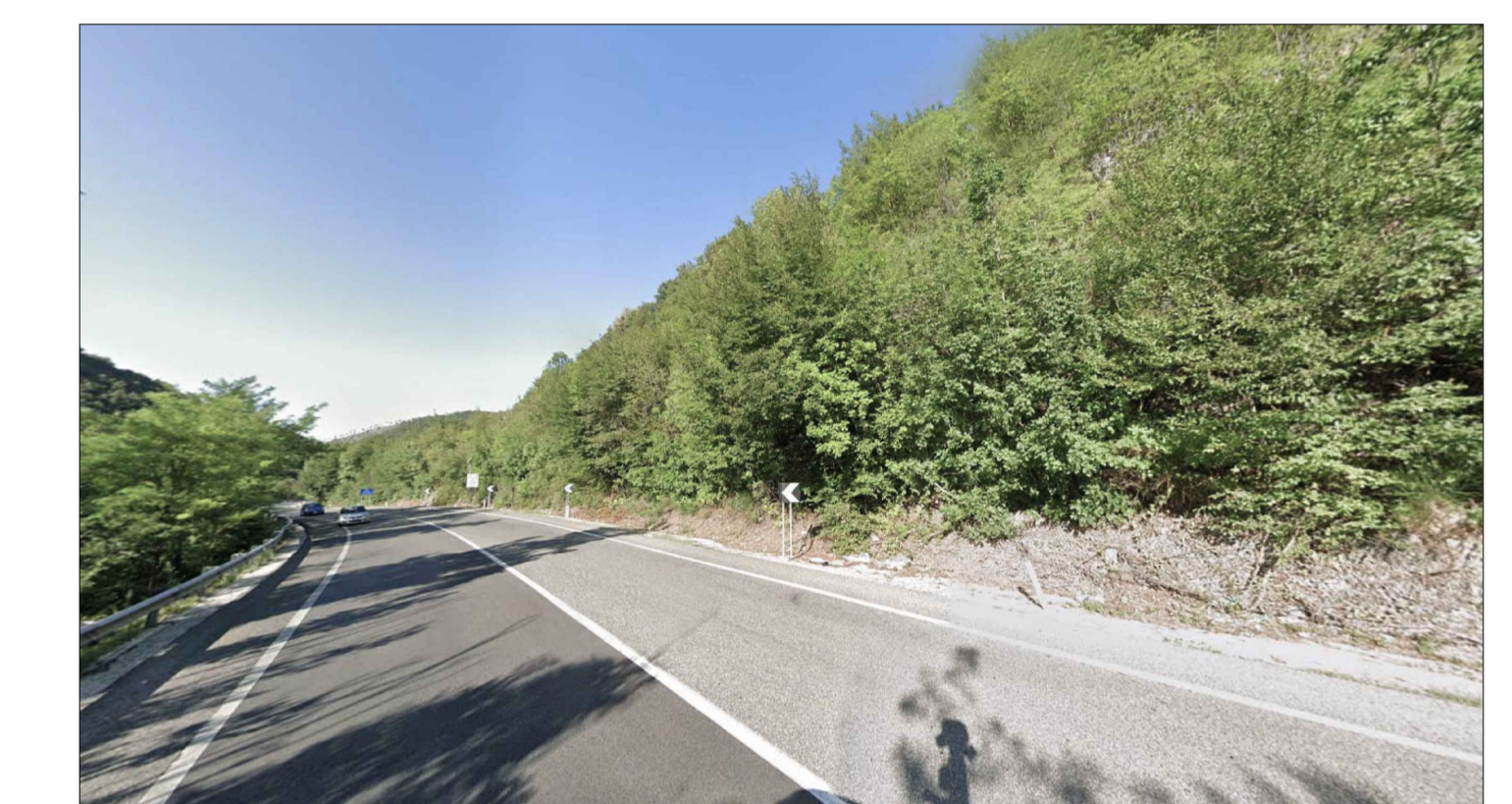
GALLERIA SAN LORENZO - LATO NORD - ANTE OPERAM
