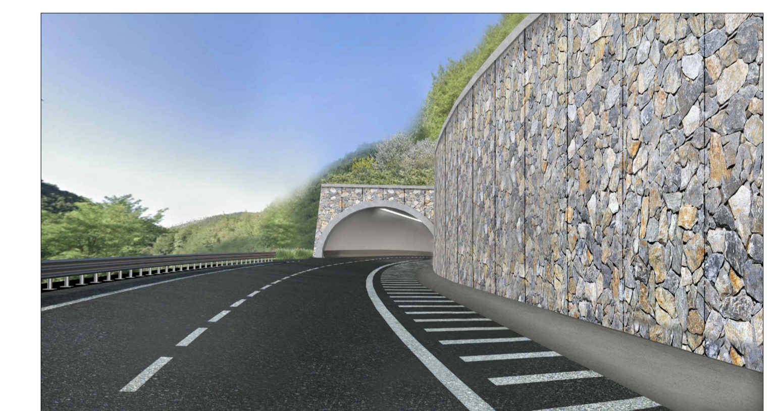
GALLERIA SAN LORENZO - LATO NORD - POST OPERAM
