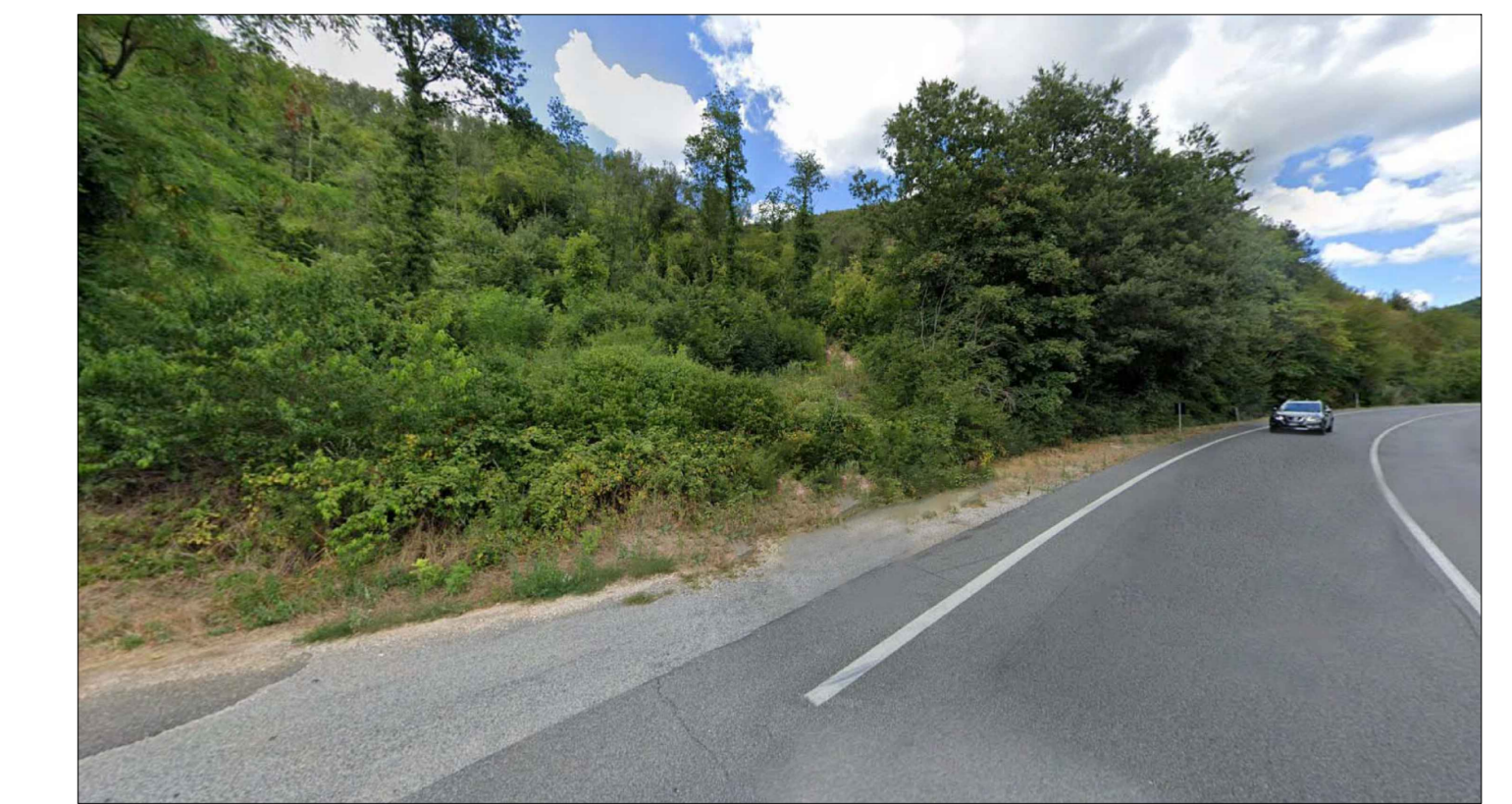
GALLERIA SAN LORENZO - LATO SUD - ANTE OPERAM
