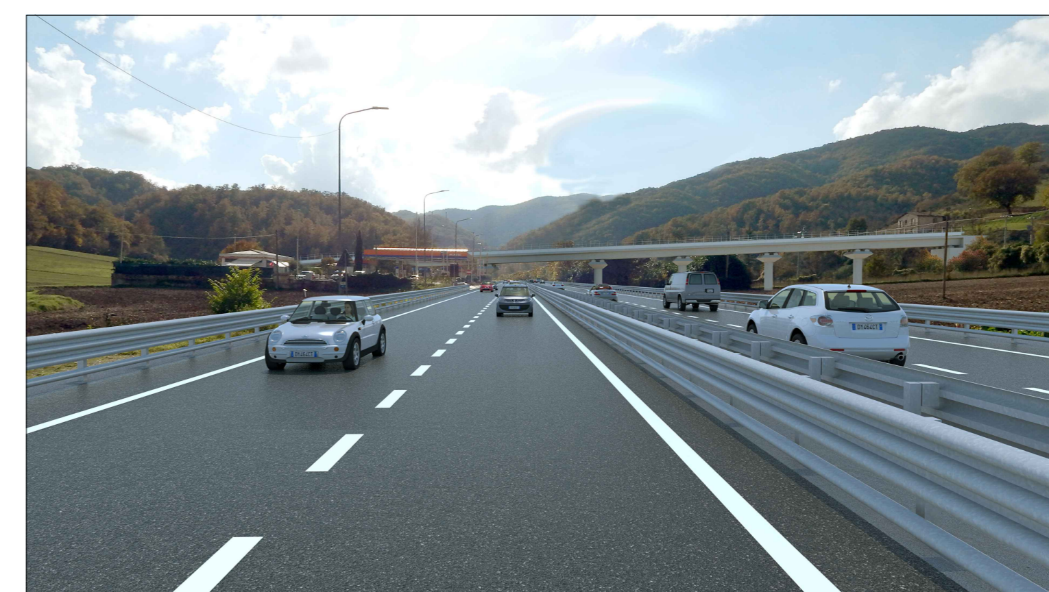
CAVALCAVIA CV02: FOTO POST OPERAM - vista direzione sud
