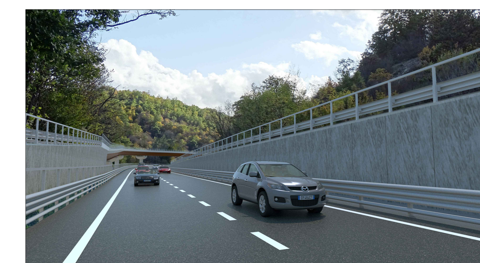
VIADOTTO VI04: FOTO POST OPERAM - vista direzione sud
