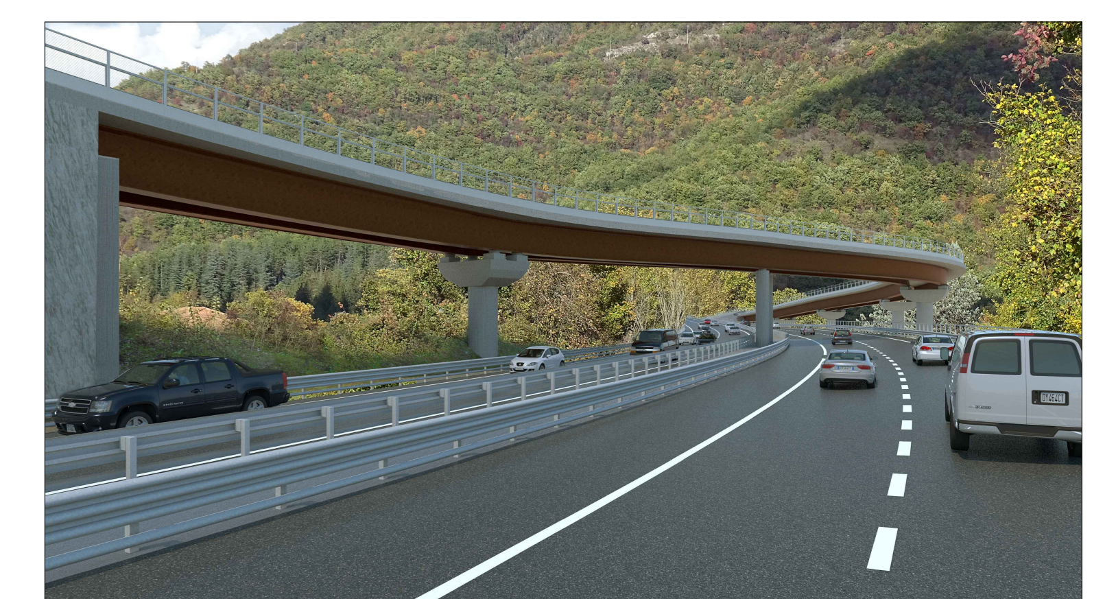
VIADOTTO VI04: FOTO POST OPERAM - vista direzione nord
