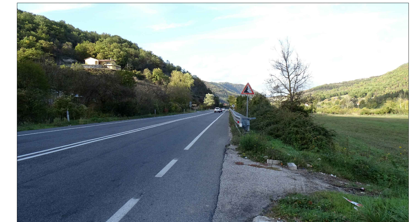
VIADOTTO VI05: FOTO ANTE OPERAM
