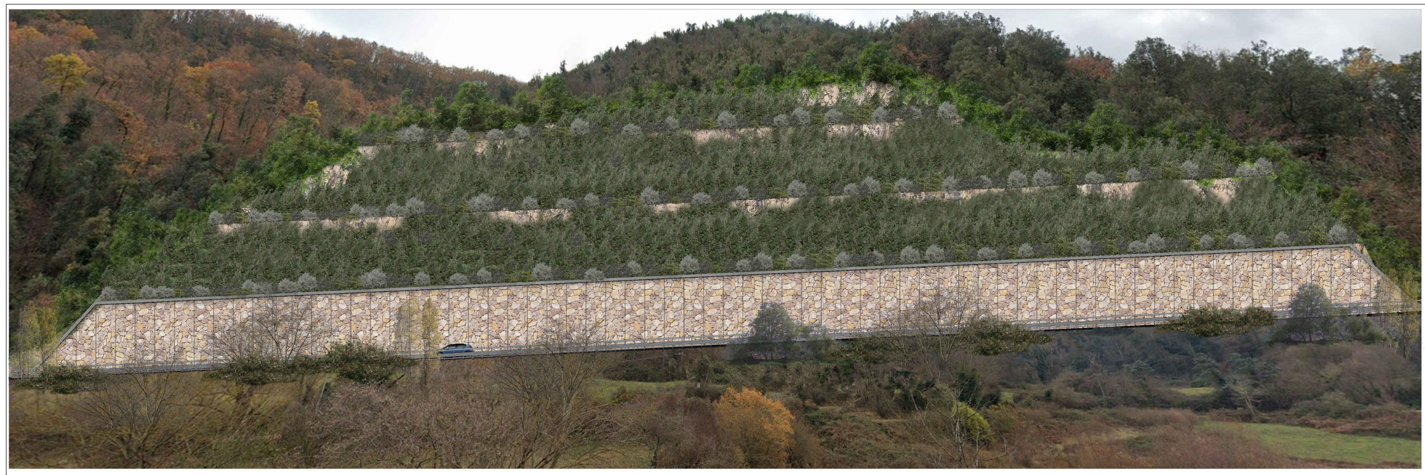
ESECUZIONE TAGLI DI VERSANTE - PROSPETTO CON FOTOSIMULAZIONE
