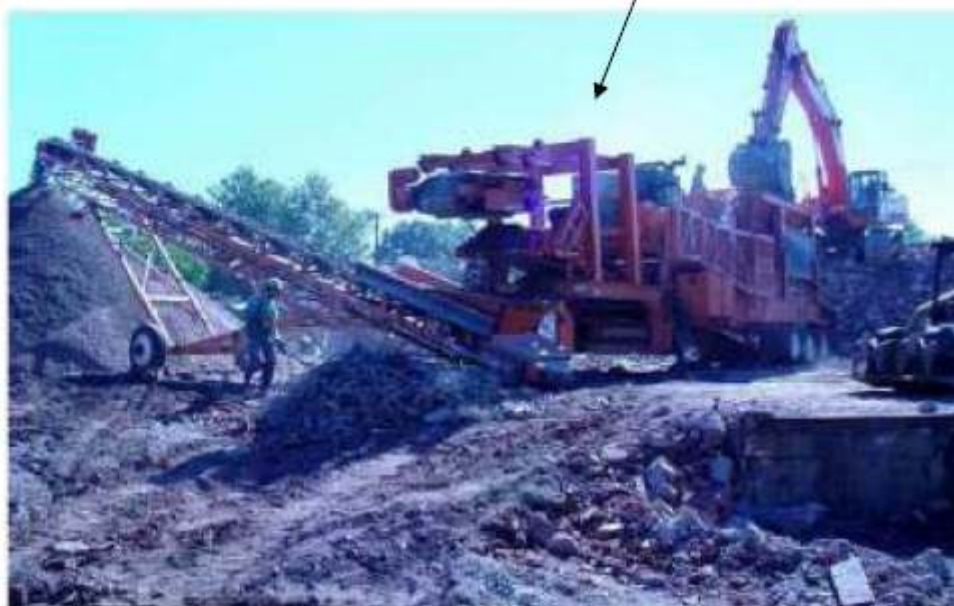
Figura 12.5. – Particolare Demolizione Fondazioni o Opere in C.A.
