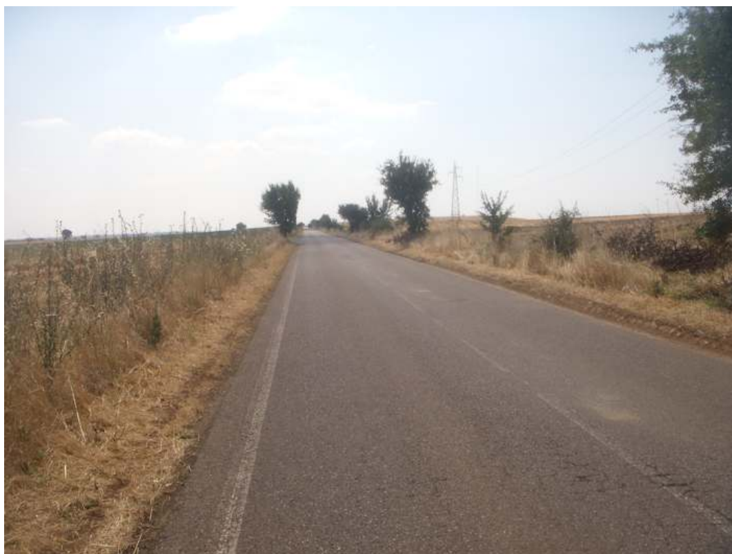
Figura 3.8. – Particolare viabilità di accesso all'area.
