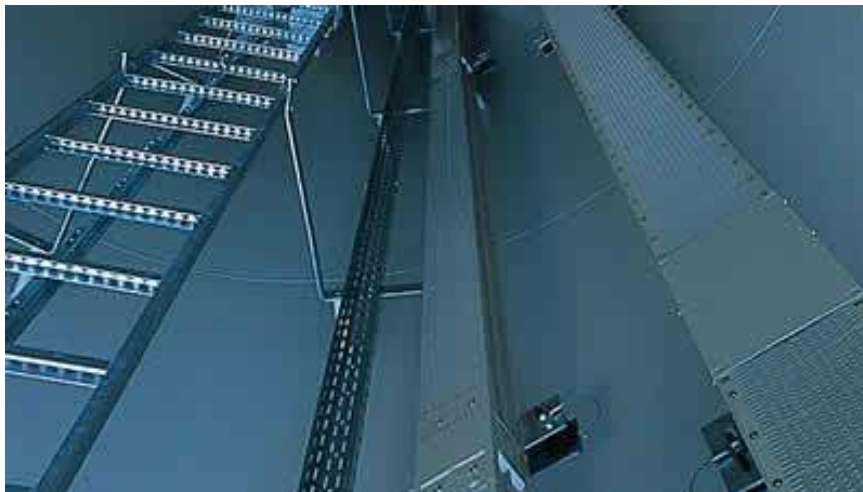
Figura 7.5. – Particolare Sbarre conduttrici.
