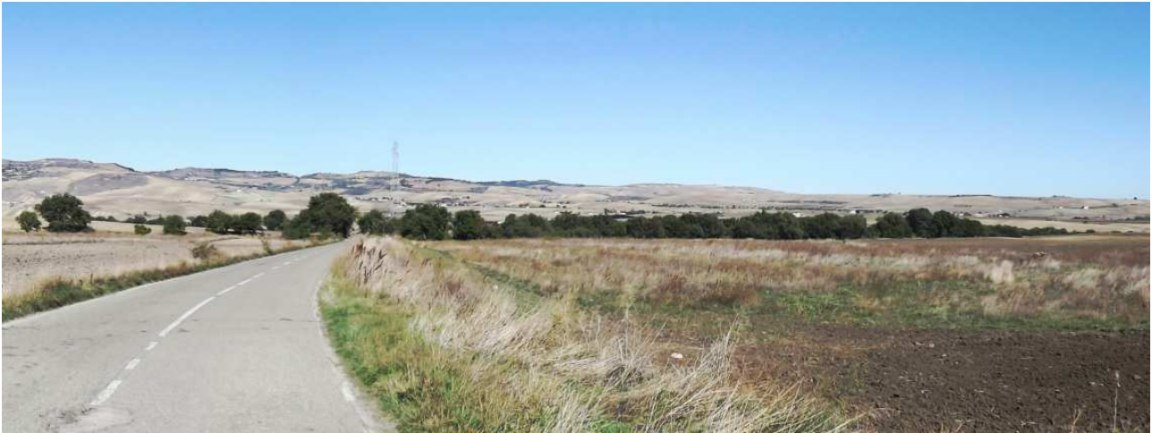
Figura 35: Panoramica attraversamento Vallone Macchione-Palmira –Vista verso Nord –ANTE OPERAM
