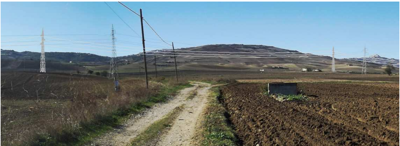
Figura 38: Fotomontaggio dell' elettrodotto in attraversamento al tratturello Monteserico-Palmira -Vista verso Sud-Ovest -POST OPERAM
