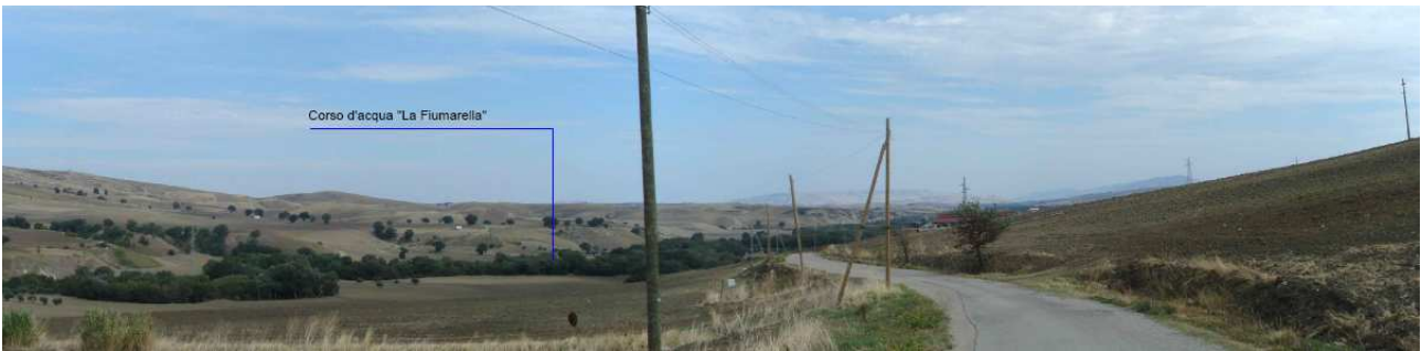
Figura 31: Panoramica attraversamento Torrente Fiumarella –Vista verso Sud Est -ANTE OPERAM
