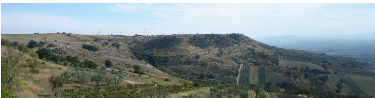
Figura 29: Panoramica linea elettrica esistente presso incrocio SP22-SP6 –Vista verso sud -ANTE OPERAM
