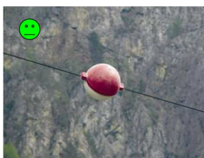
Figura 46: Sfera di poliuretano, su cavo aereo
