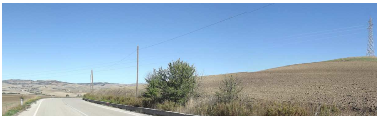
Figura 15: Panoramica attraversamento al regio tratturo Tolve – Genzano –Vista verso Nord –ANTE OPERAM
