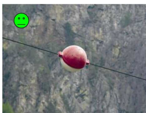
Figura 22: Sfera di poliuretano, su cavo aereo
