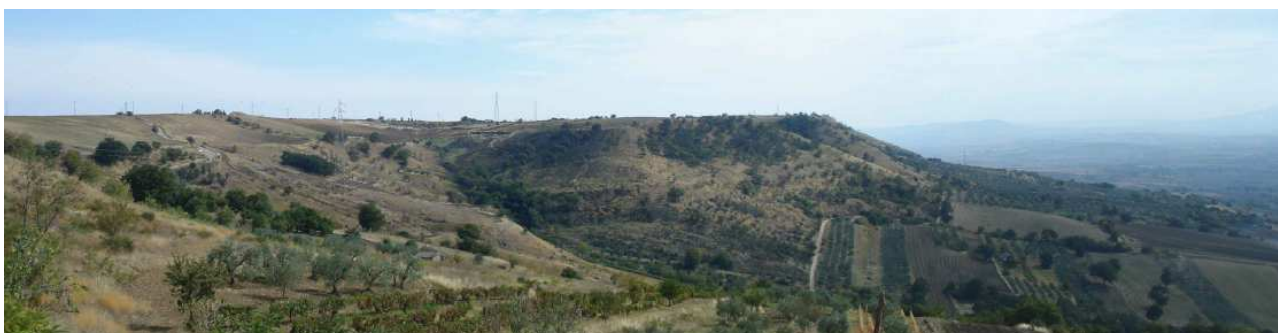
Figura 7: Panoramica linea elettrica esistente presso incrocio SP22-SP6 –Vista verso sud -ANTE OPERAM
