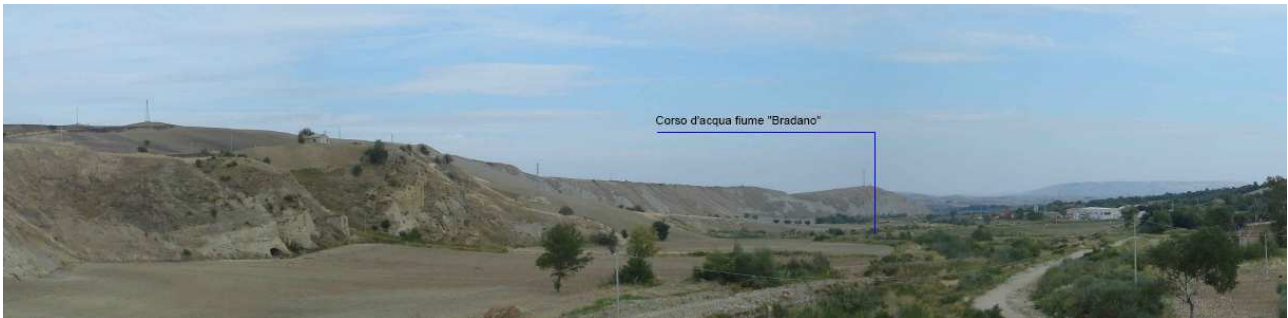
Figura 11: Panoramica attraversamento fiume Bradano –Vista verso Est -ANTE OPERAM
