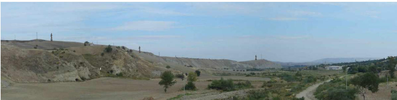
Figura 12: Fotomontaggio dell' elettrodotto in attraversamento al Fiume Bradano –Vista verso Est -POST OPERAM
