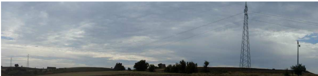
Figura 5: Panoramica linea elettrica esistente presso area SSE di Banzi –Vista verso sud-Est-ANTE OPERAM
