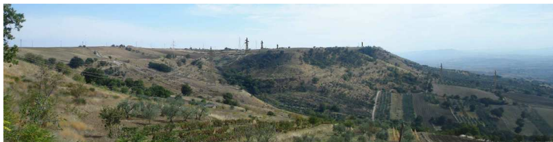
Figura 40: Foto inserimento elettrodotto in sorvolo su aree gravate da usi civici e macchia boscata, con evidenza di numerosi elementi infrastrutturali già consolidati nell'ar
