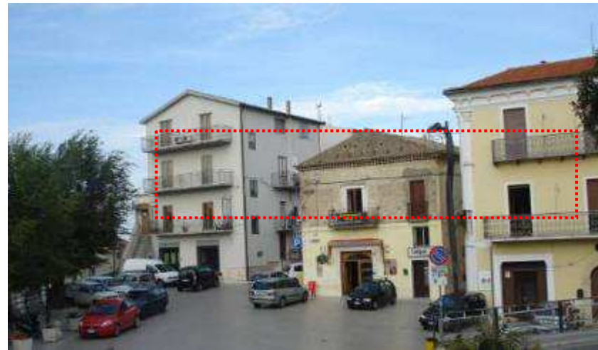
Figura 78: Ripresa 17- Ripresa dal centro di Oppido la vista è occultata dagli edifici esistenti;
