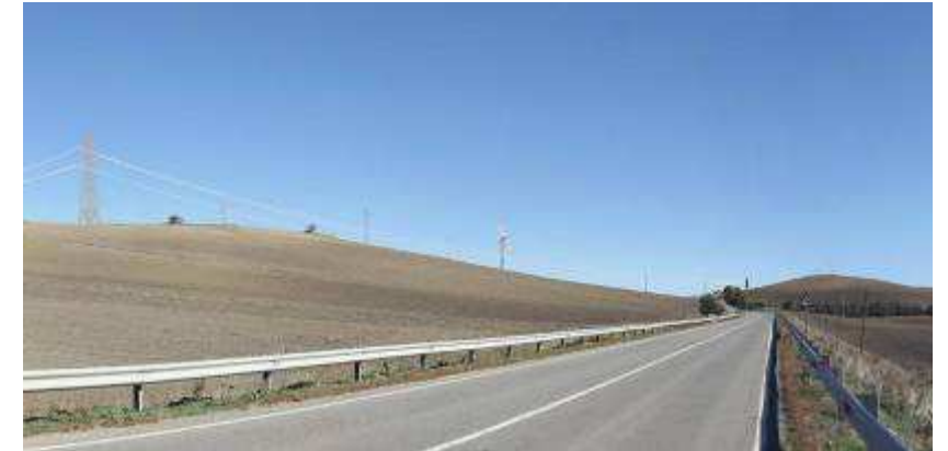
Figura 60: Foto inserimento Area tratturo –SS 92BIS, vista verso EST
