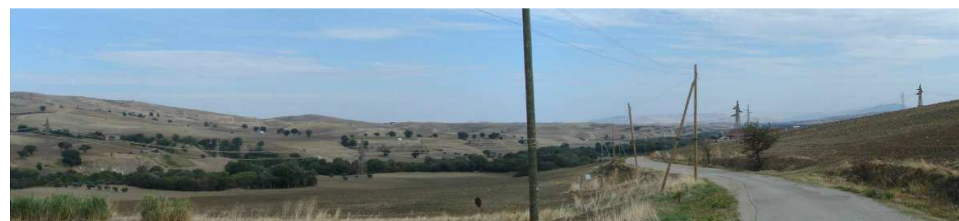
Figura 42: Foto inserimento linea AT di progetto su torrente Fiumarella, già ricca di elementi infrastrutturali rispetto ai quali la linea di progetto si confonde.
