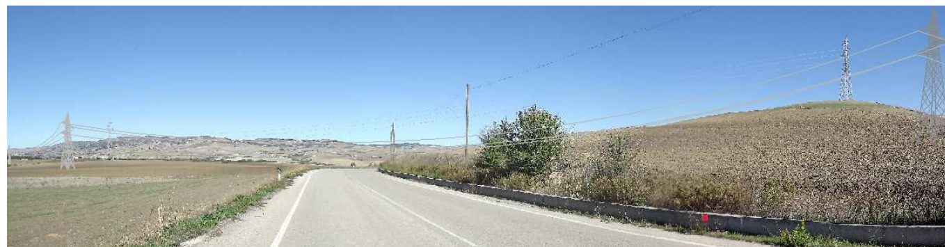
Figura 55: Fotomontaggio della linea aerea che attraversa in sorvolo la sede del tratturo
