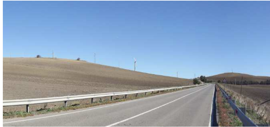
Figura 57: Ripresa fotografica (FOTO 10) Area tratturo –SS 92BIS, verso est-
