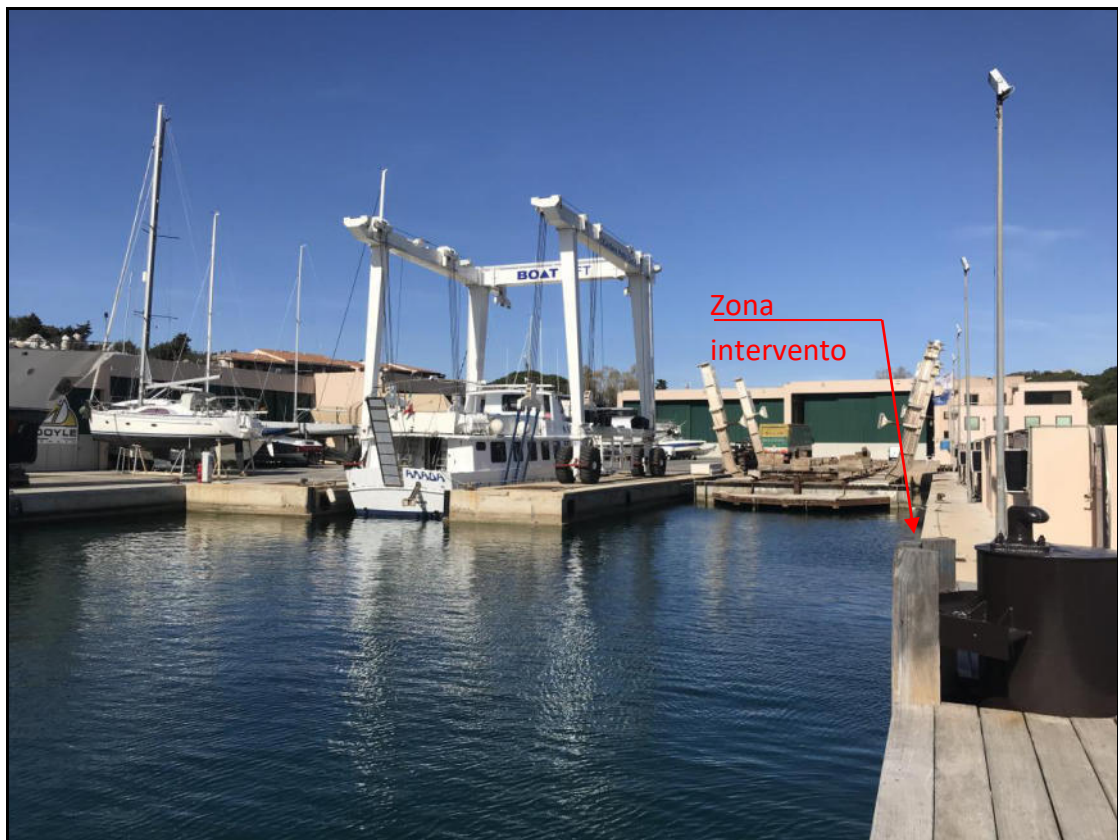
VISTA ZONA DI INTERVENTO BACINO
