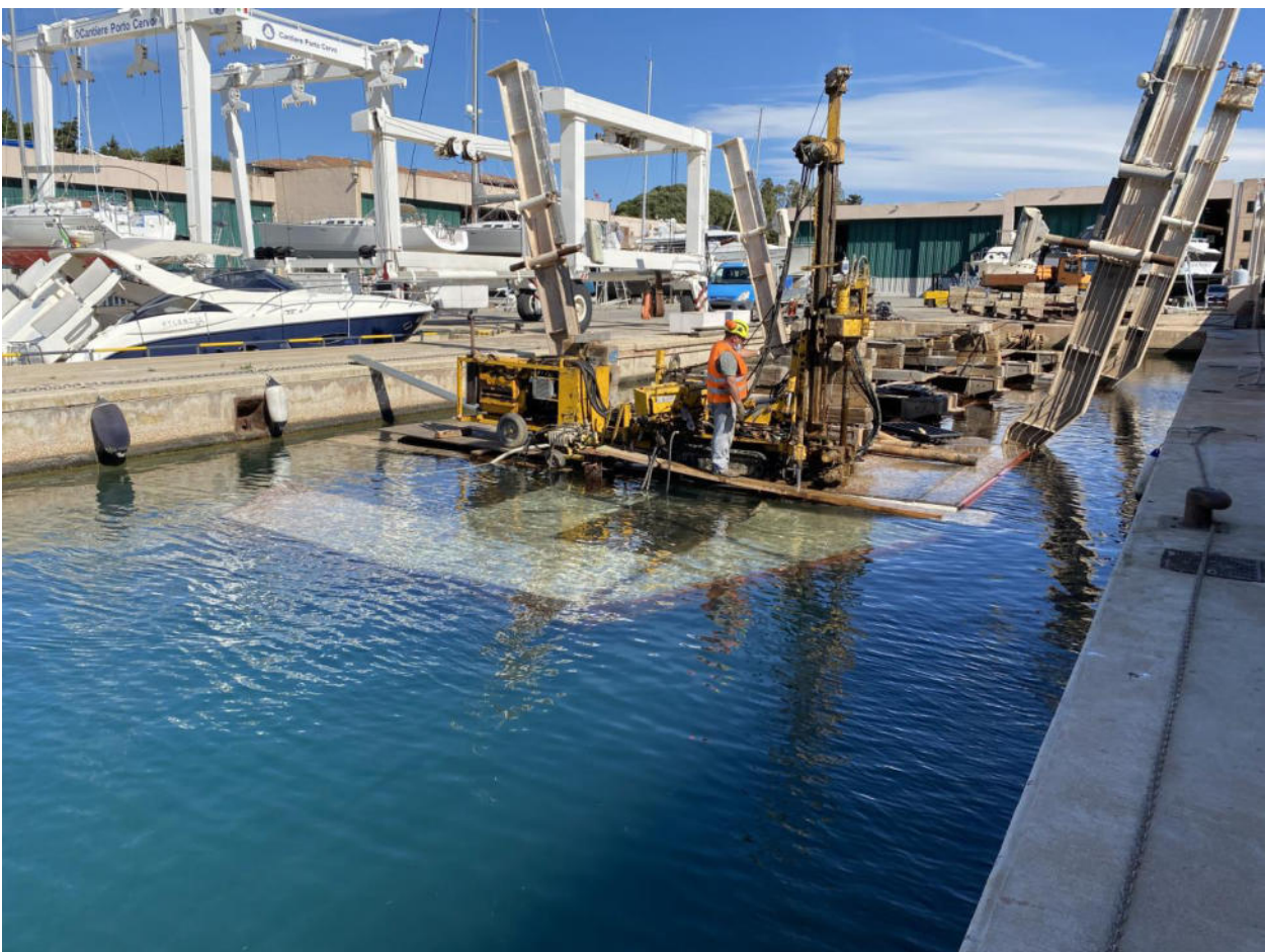
Foto esecuzione sondaggi zona scalo
