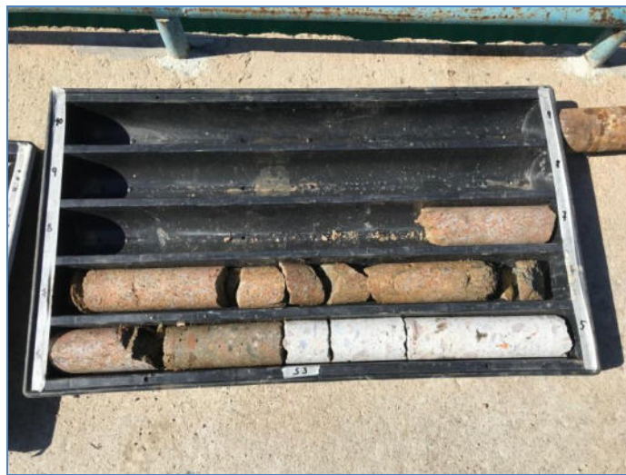
Calcestruzzo fino a quota 5,80
