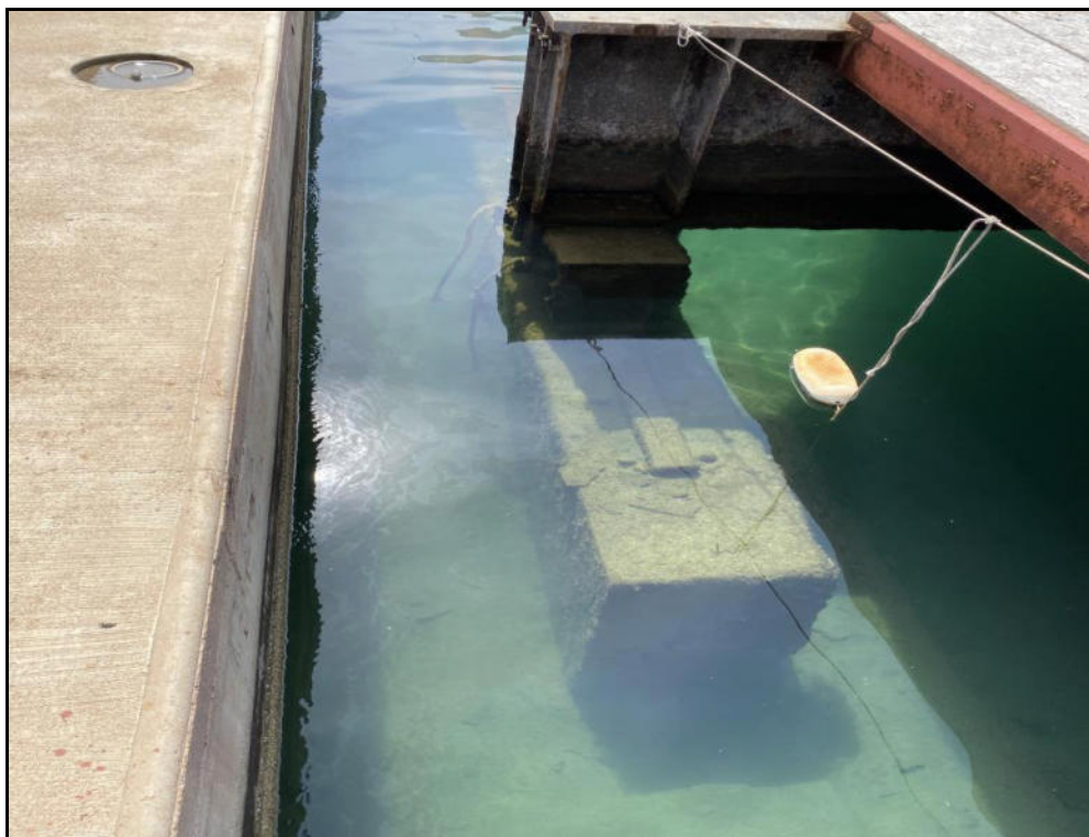
DETTAGLIO TRAVE APPOGGIO SCALO DA DEMOLIRE SX E DX INGLOBARE NEL GETTO
