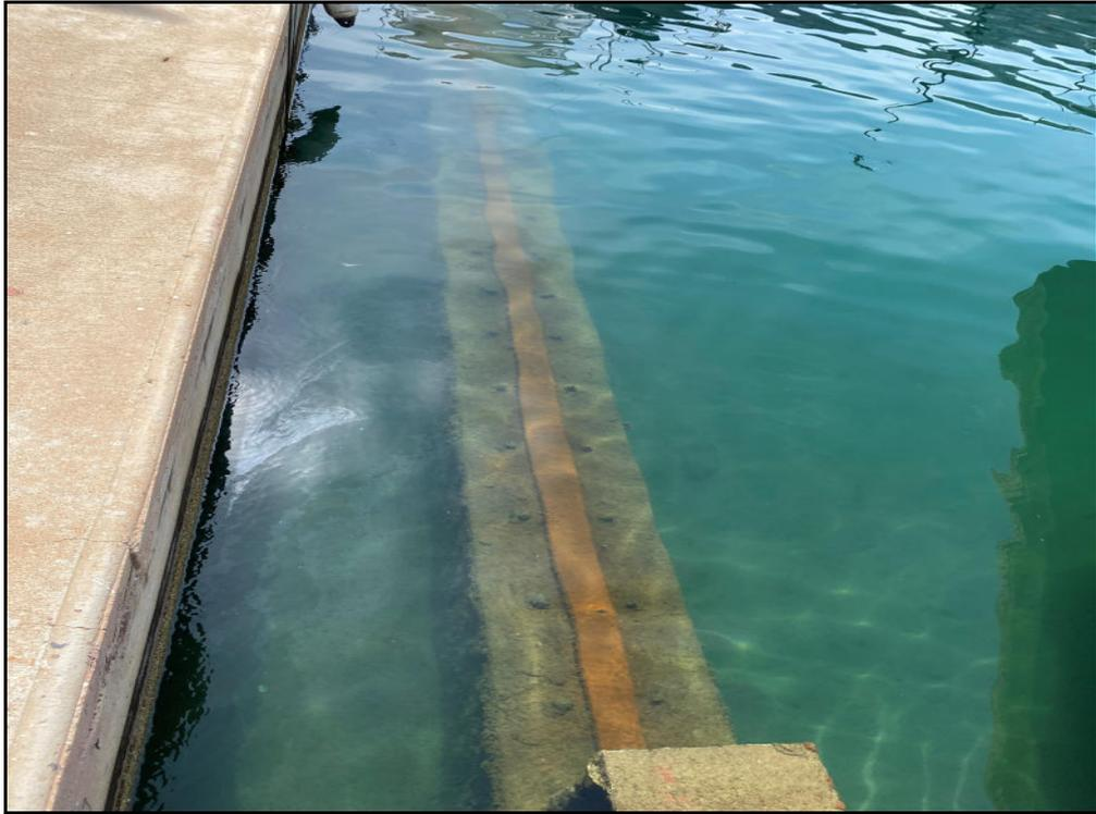
Foto via di corsa in C.a. che verrà inglobata all'interno del getto per realizzare la nuova via di corsa delle ruote del travel sul lato sinistro del bacino
