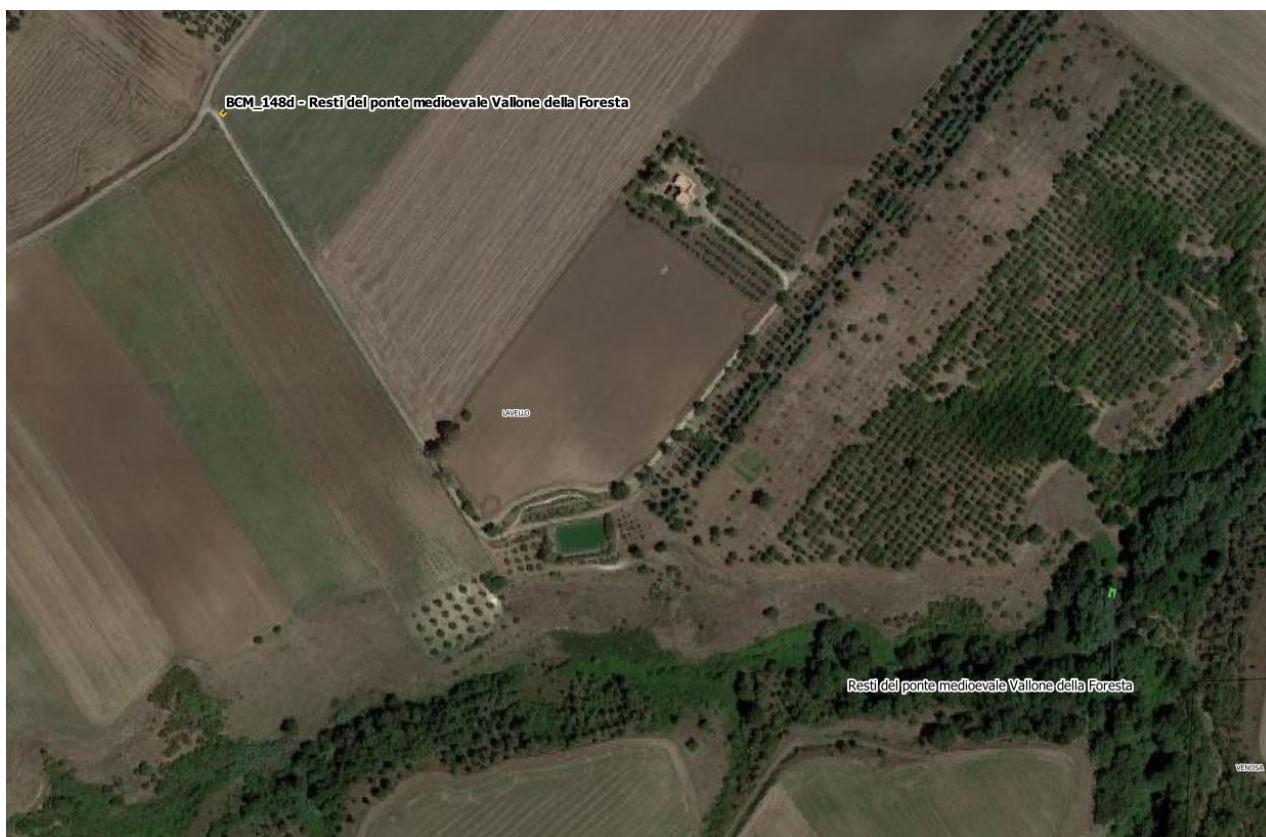
Foto 8 –Punto di ripresa fotografica e dell'area di interesse " Resti del ponte medioevale Vallone della Foresta "
