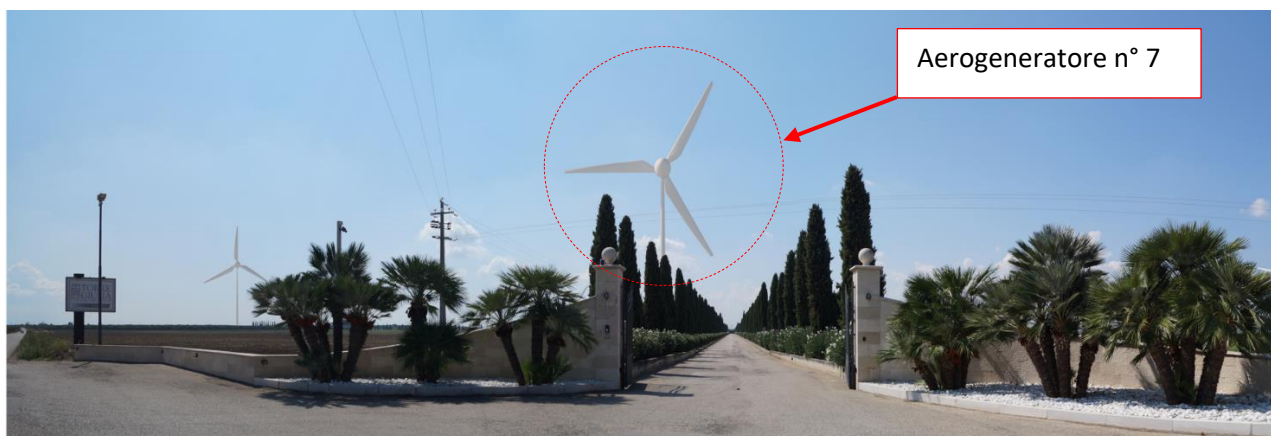
Strada di accesso a Torre Giulia - stato dei luoghi ex post
