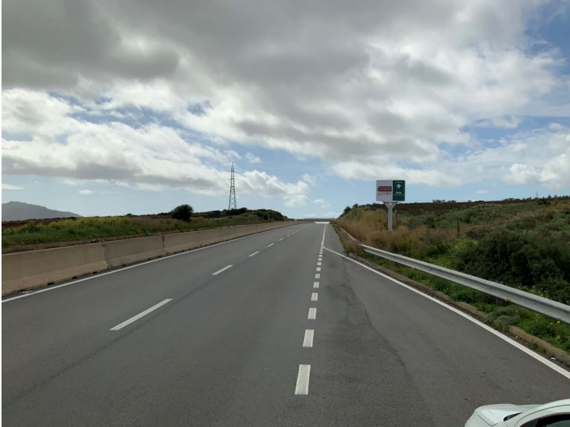
Foto 1 – Vista panoramica del tratto di strada oggetto di intervento, all'altezza del km 21+600.
