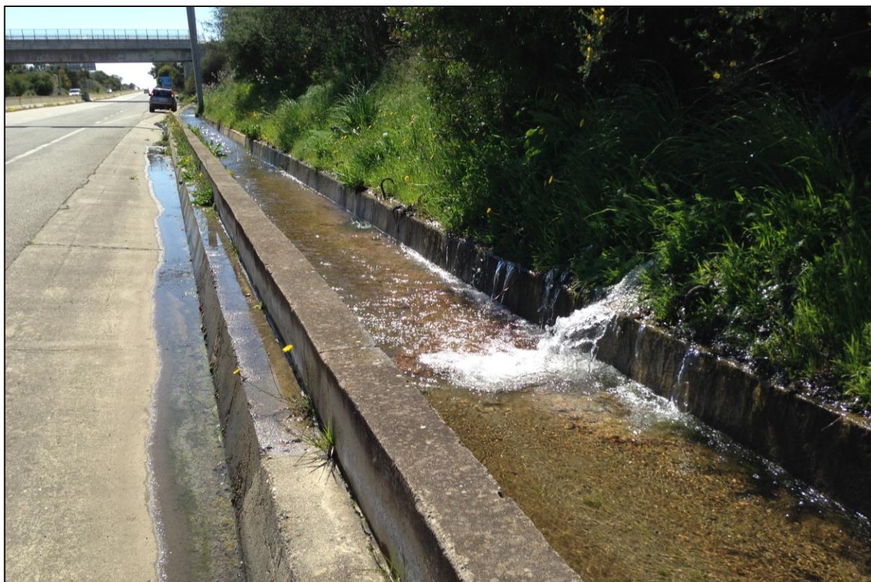
Foto 5 e 6 - Risorgenze idriche dai glaci rilevabili stagionalmente circa a partire dal km 22+500.
