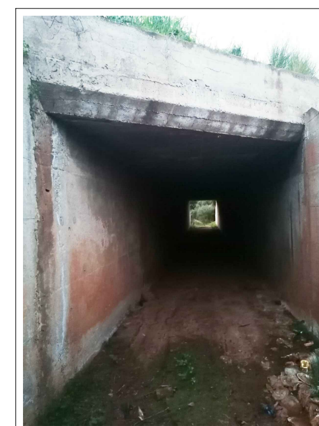
IMBOCCO LATO EST
