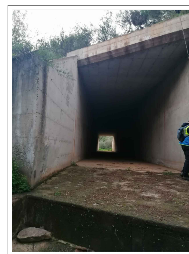
IMBOCCO LATO EST
