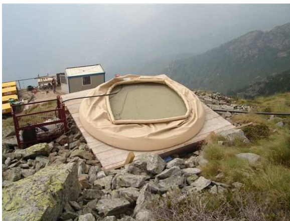
Figura 7:: immagini relative a micro - cantieri in quota. Nelle aree acclivi si realizzano più piattaforme per depositare materiali e macchinari. Si realizzano dei bivacchi necessari alle maestranze in caso di repentino cambio di tempo. Sarà necessario per ogni micro cantiere costruire anche delle piazzole per la posa dell'elicottero.
