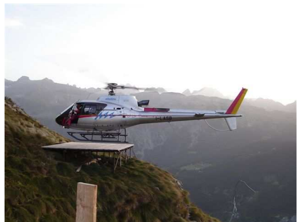
Figura 7:: immagini relative a micro - cantieri in quota. Nelle aree acclivi si realizzano più piattaforme per depositare materiali e macchinari. Si realizzano dei bivacchi necessari alle maestranze in caso di repentino cambio di tempo. Sarà necessario per ogni micro cantiere costruire anche delle piazzole per la posa dell'elicottero.
