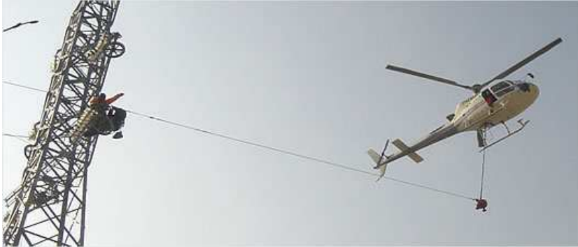
Figura 8: Tesatura dei cavi con elicottero
