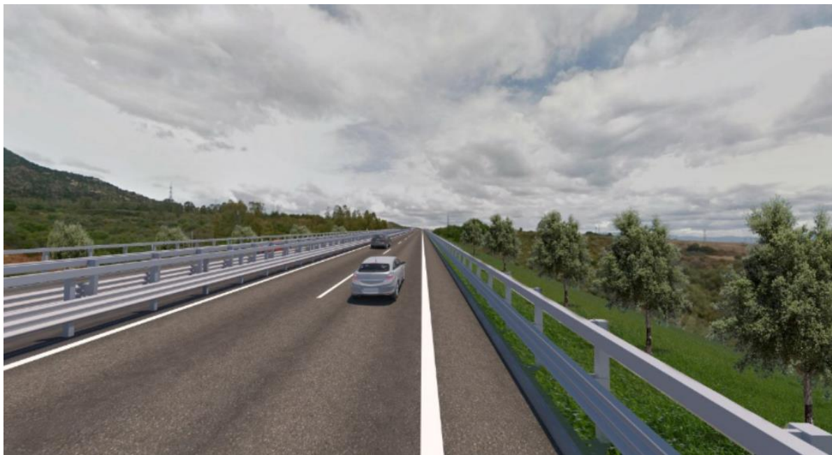
Figura 26- Post operam punto di vista 2
