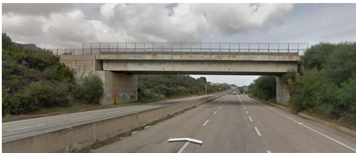
Figura 22 – Situazione geometrica della strada in corrispondenza del cavalcavia
