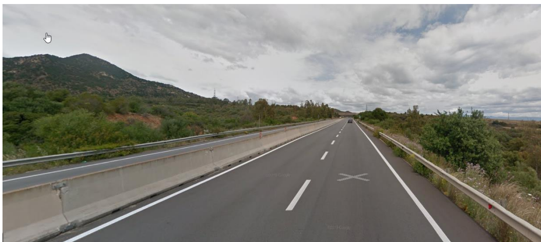
Figura 2: Stato attuale tratta "Perimetrale Consortile"
