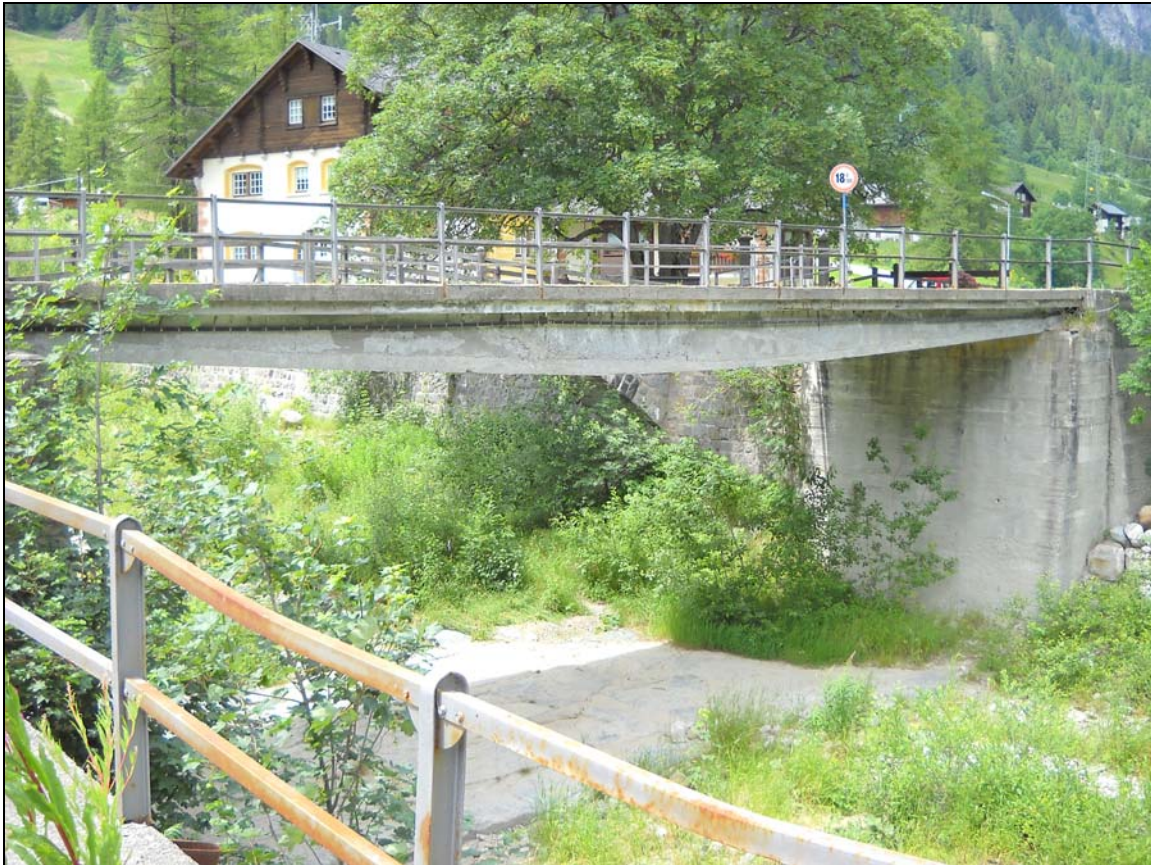
Fig. 16 Valdo – Vista del ponte in c.a. per la viabilità ordinaria.
