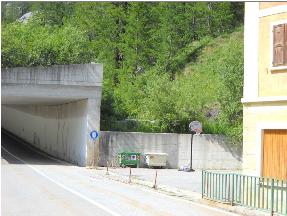
Fig. 19 Ingresso della prima galleria che sale alla cascata della Frua con il punto per il passaggio a monte della stessa della nuova linea da 132 kV in cavo interrato per il collegamento con il nuovo palo porta-terminali n°18.
