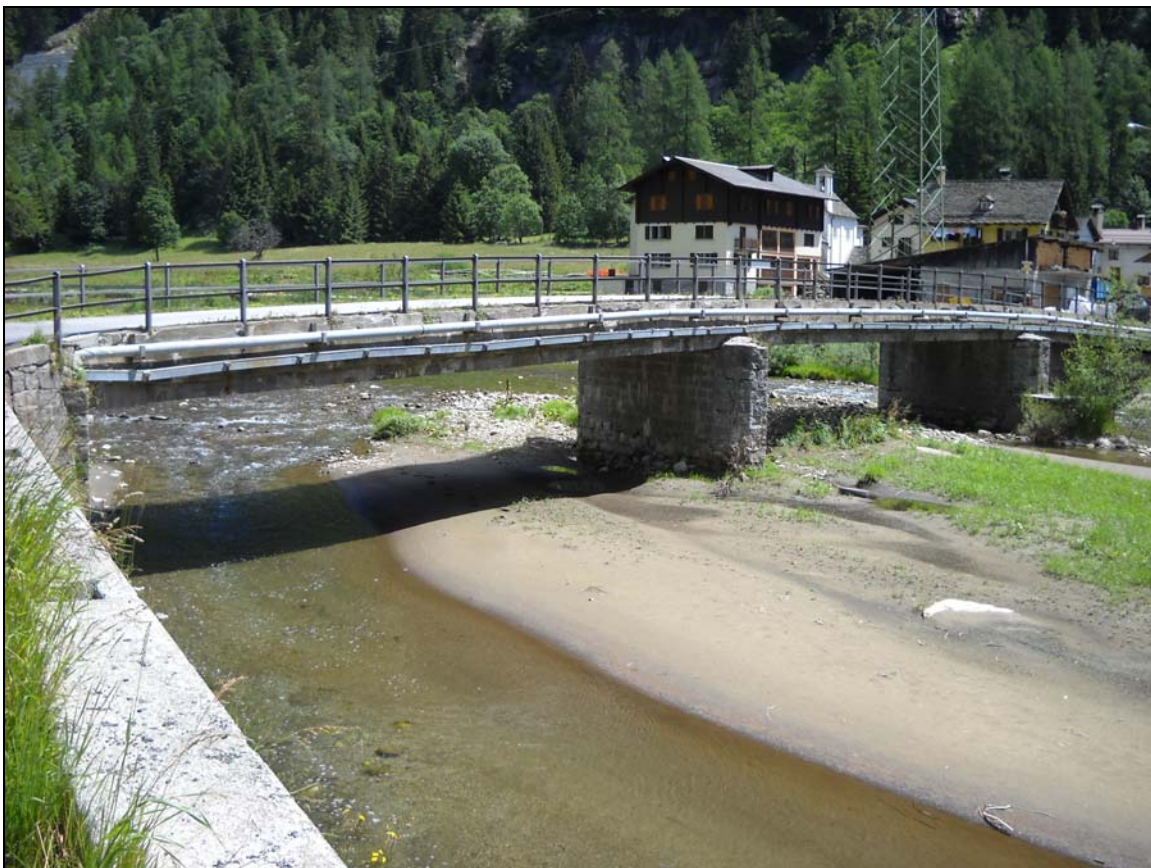
Fig. 15 Fondovalle – Ponte sul Fiume Toce che porta all’abitato di Fondovalle.
