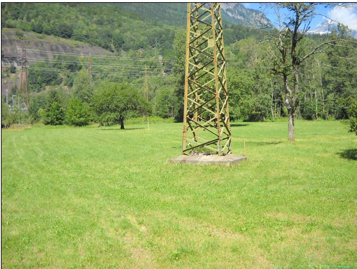
Fig. 9 Piana di Verampio – Zona di passaggio della campata tra i sostegni n°78 e n°79 dell'elettrodotto "Ponte V.F.-Verampio".
