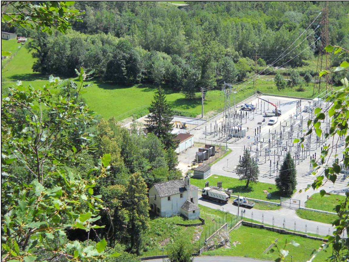
Fig. 10 S.E. di Verampio – Vista dal lato nord in corrispondenza della ubicazione del sostegno n°79 dell'elettrodotto "Ponte V.F.-Verampio".
