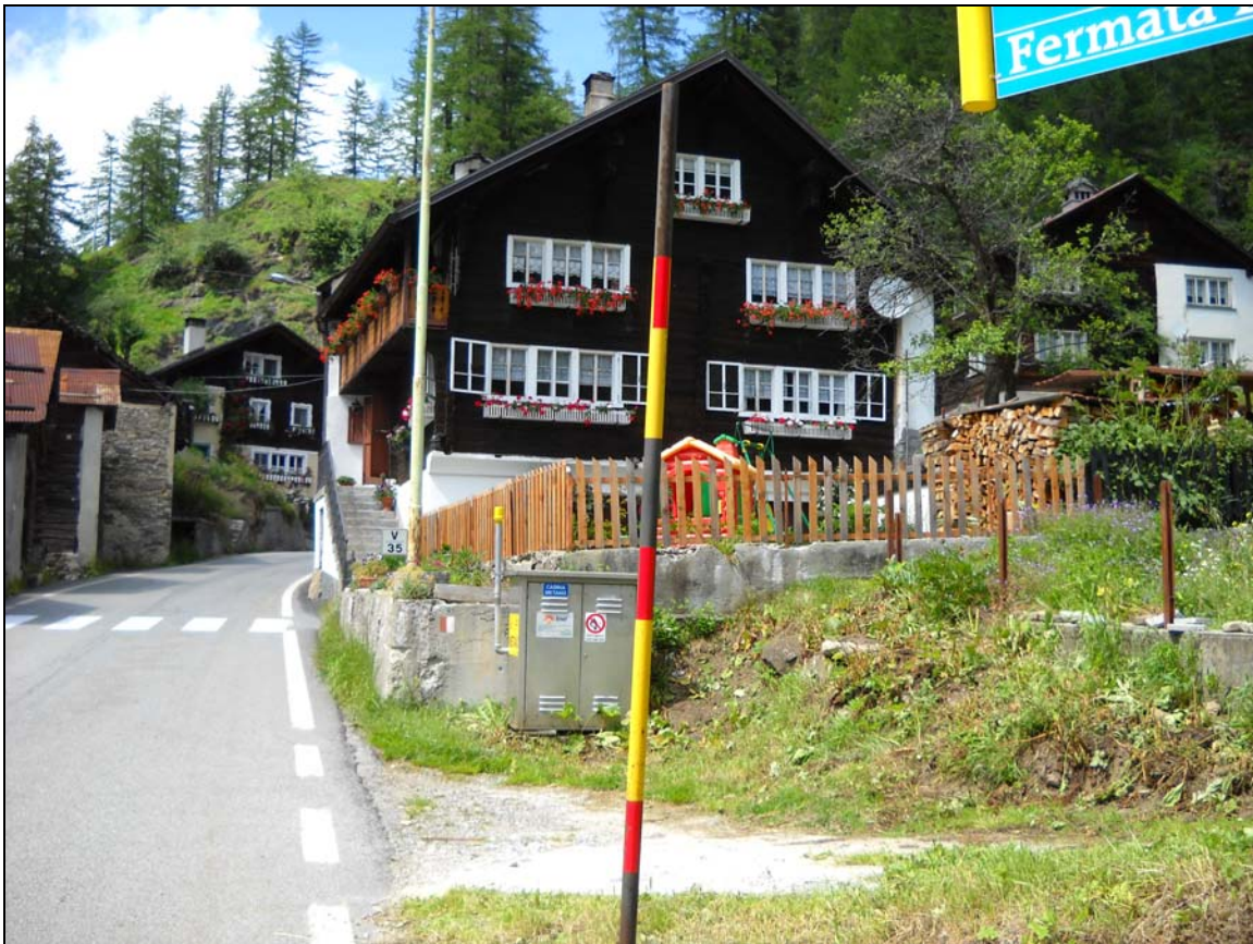
Fig. 26 Località Grovella – Cabina di riduzione della Società ENEL S.p.a. ubicata in prossimità della S.S. 659.
