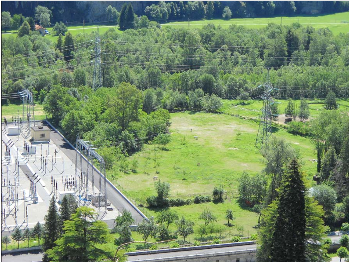
Fig. 12 S.E. di Verampio – Vista dal lato sud in corrispondenza della ubicazione del sostegno n°74 dell'elettrodotto "Ponte V.F.-Verampio".
