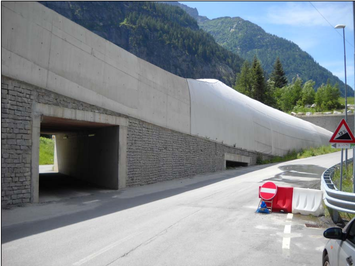
Fig. 14 S.E. di Fondovalle – Vista della S.S. 659 in corrispondenza dell’ingresso in galleria dalla strada di accesso alla S.E. di Fondovalle.
