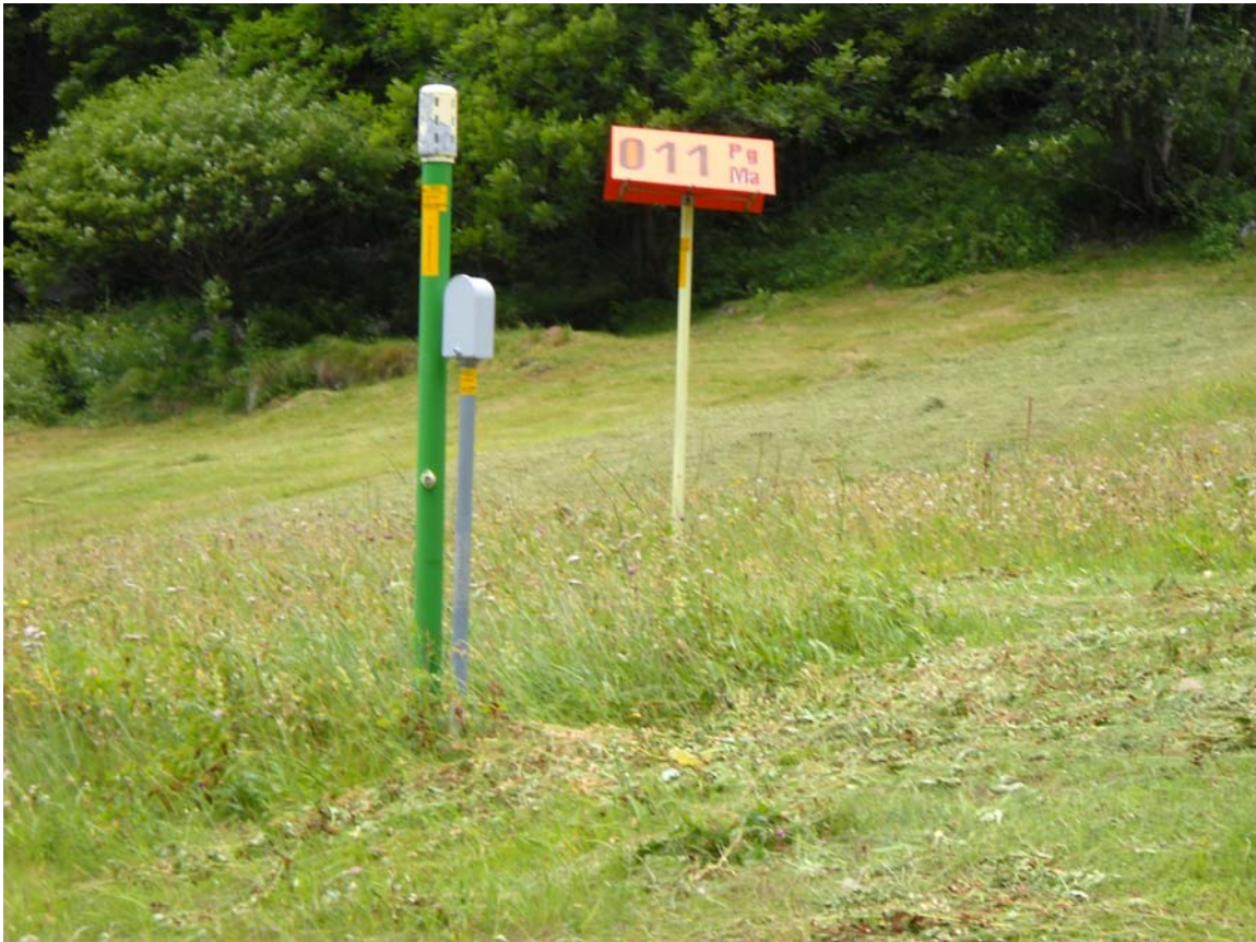
Fig. 22 Località Chiesa – Punto di attraversamento del metanodotto internazionale SNAM S.p.a con la S.S. 659 (vista della palina segnalatrice e dello sfiato di drenaggio)
