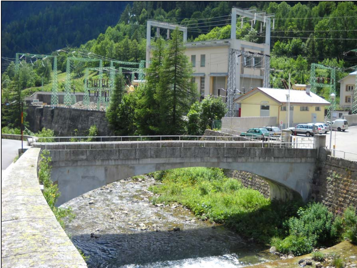
Fig. 18 S.E. di Ponte V.F. – Vista della S.E. dalla S.S. 659 e relativo ponte di accesso.
