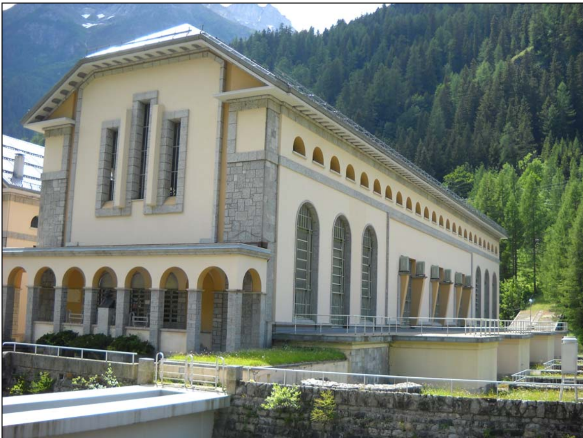
Fig. 7 S.E. di Ponte V.F. - Vista dalla S.S. 659.
