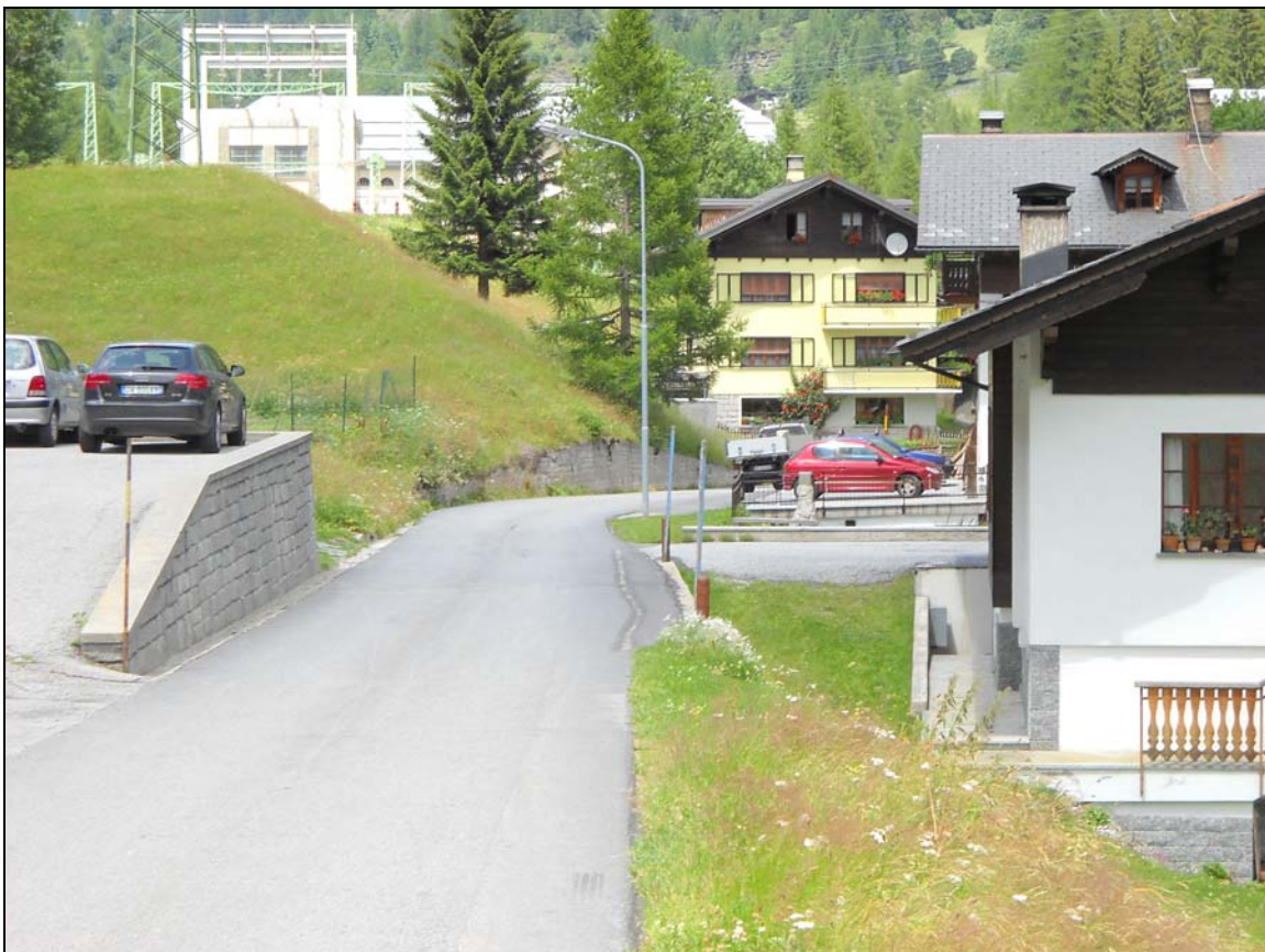
Fig. 17 Ponte – Punto di deviazione dalla sede stradale per l'ingresso dell'elettrodotto alla S.E. di Ponte V.F. sullo sfondo.
