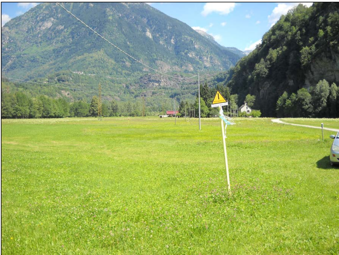
Fig. 11 Piana di Verampio – Zona di passaggio della campata tra i sostegni n°72 e n°73 dell'elettrodotto "All'Acqua-Verampio" a S/E della S.E. di Verampio.
