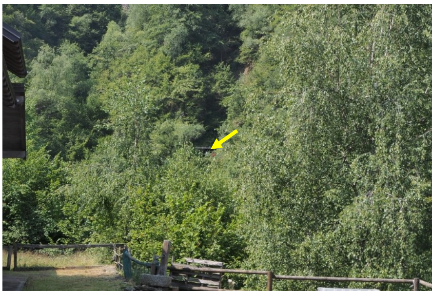
Figura 4: Vista dell'imbocco dalla Ca' Bianca (zoom).
