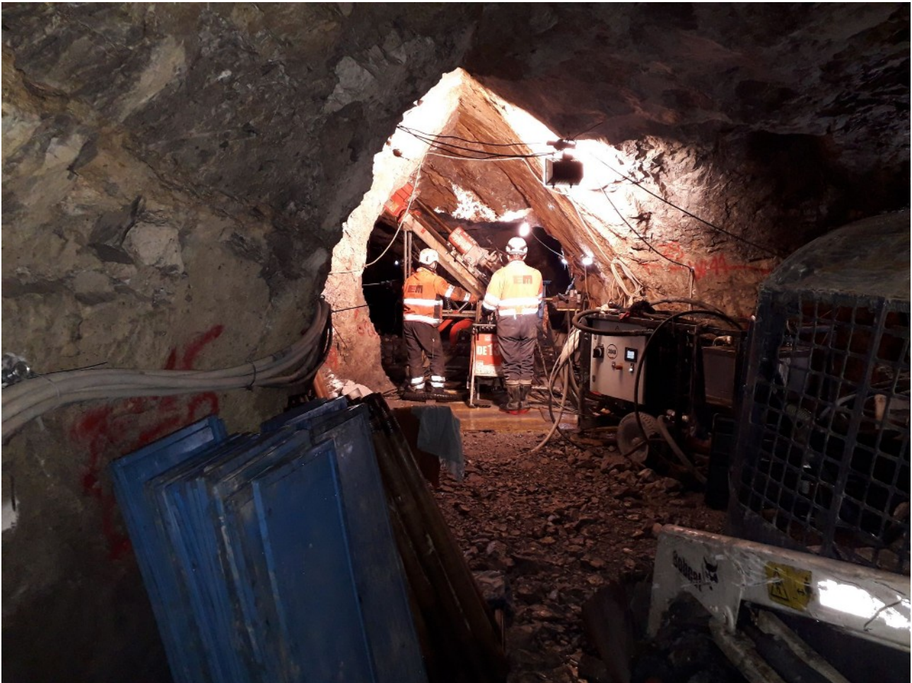
Foto 1: Sondaggio in galleria a piccola sezione e attrezzature di cantiere.
