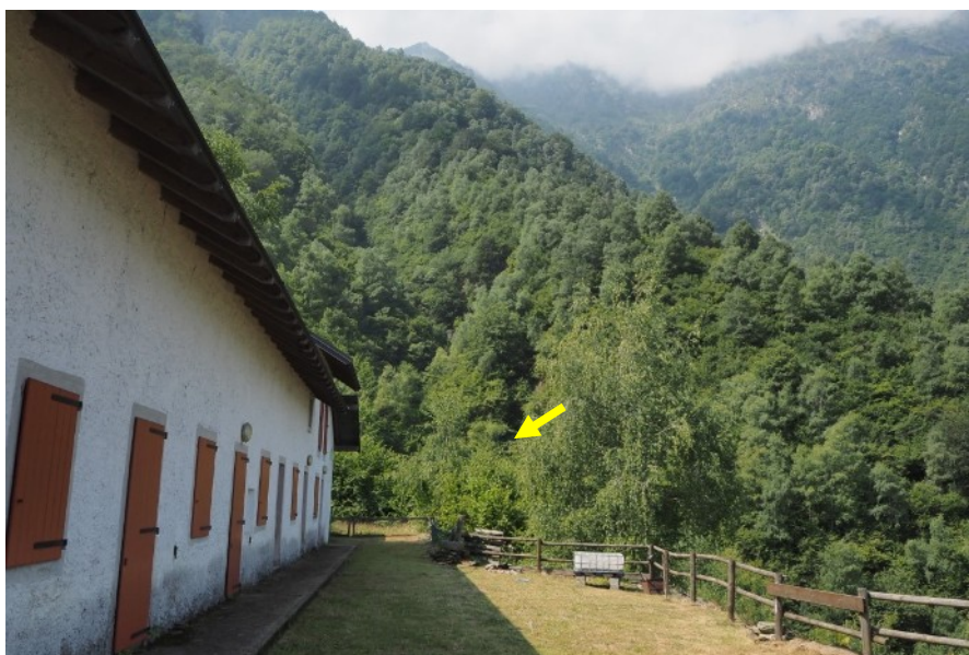
Figura 3: Vista dell'imbocco del Livello -2 dalla Ca' Bianca (o Casa Fontan)
