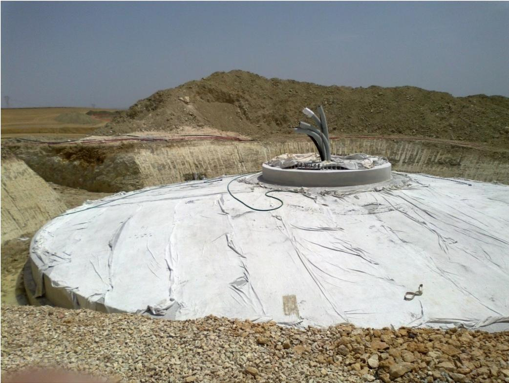
*Figura 4 Plinto gettato e ricoperto con telo bagnato per ridurre il ritiro in caso di alte temperature*
