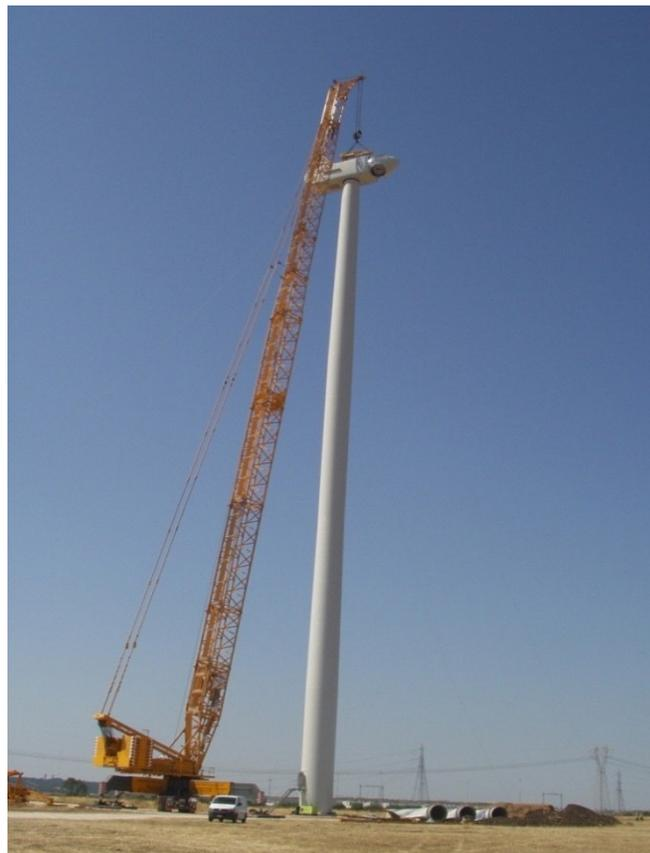
*Figura 10 Fasi di montaggio navicella Vestas*
