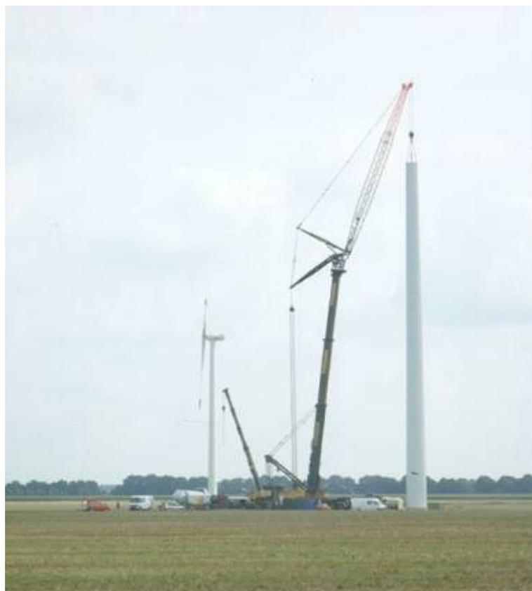
*Figura 7 Montaggio secondo troncone torre*
