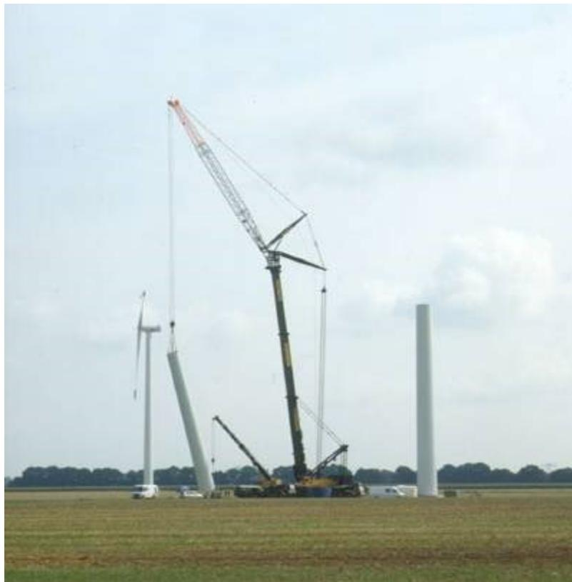
*Figura 5 Montaggio secondo troncone torre*
