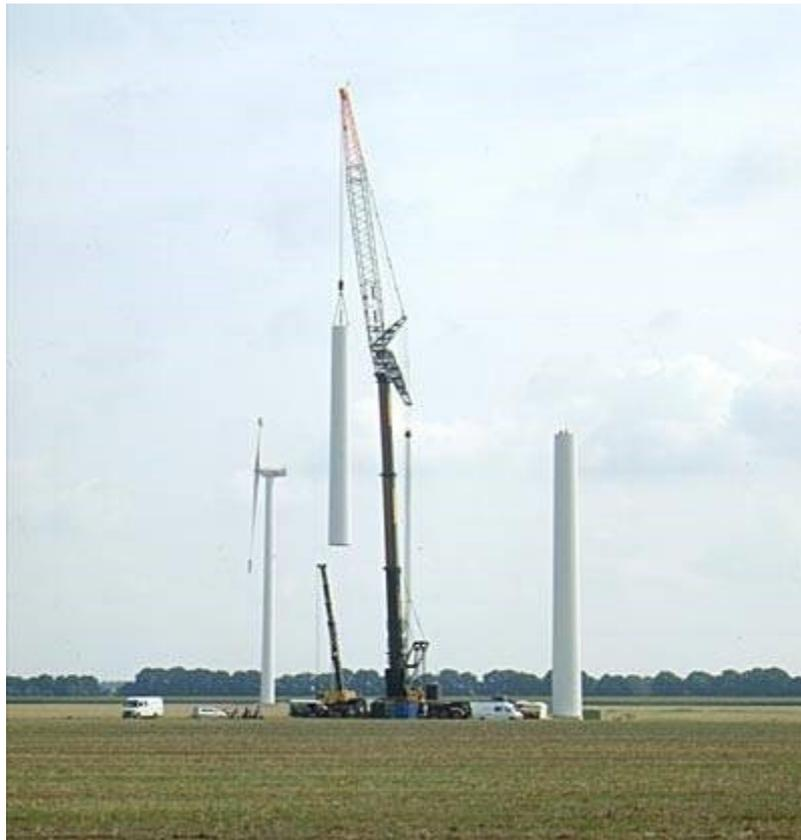
*Figura 6 Montaggio secondo troncone torre*
