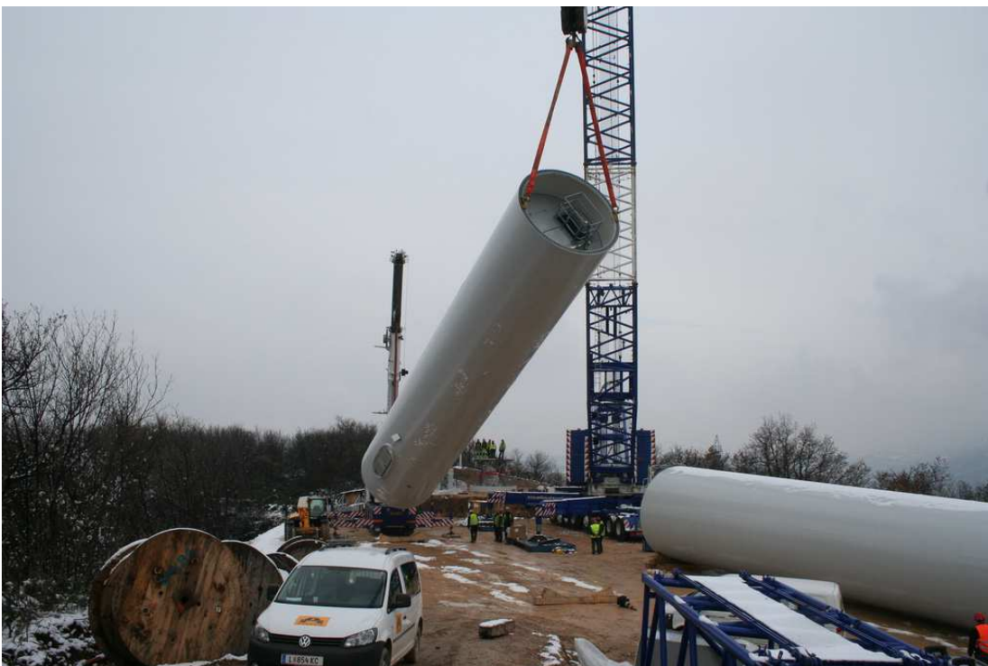
Figura 3. Smontaggio dei tronchi
