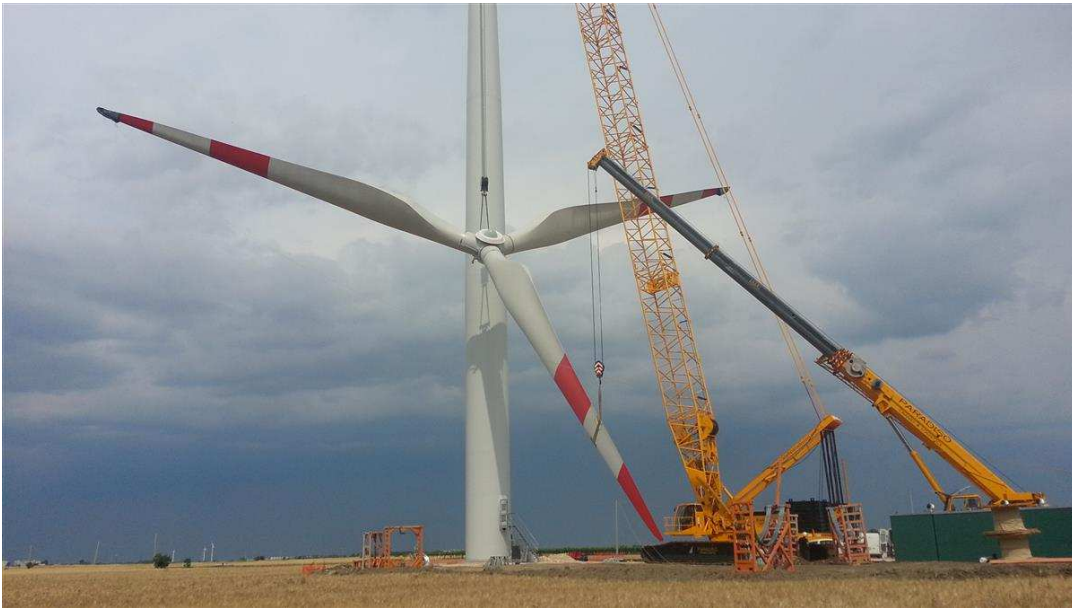
Figura 2. Smontaggio delle pale
