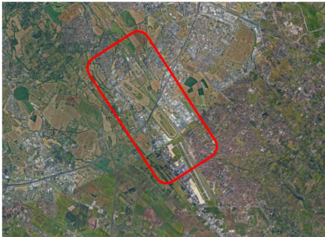
Figura 2-1 Vista aerea dell'inquadramento generale dell'intervento oggetto di studio
