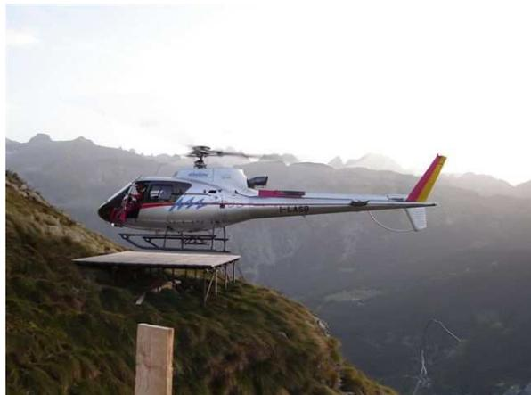
Figura 3-19: immagini relative a micro - cantieri in quota. Nelle aree acclivi si realizzano più piattaforme per depositare materiali e macchinari. Si realizzano dei bivacchi necessari alle maestranze in caso di repentino cambio di tempo. Sarà necessario per ogni micro cantiere costruire anche delle piazzole per la posa dell'elicottero.
