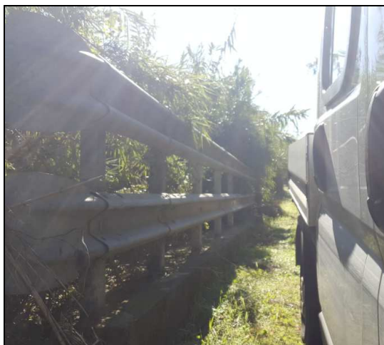
Alcune immagini del ponticello in c.a., con evidenza del cordolo sormontato da guard-rail
