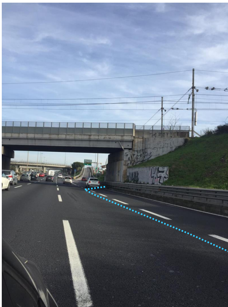
Foto carreggiata esterna del GRA, con impronta indicativa dell'isola di lavoro relativa alla Spalla B (lato Ciampino)
