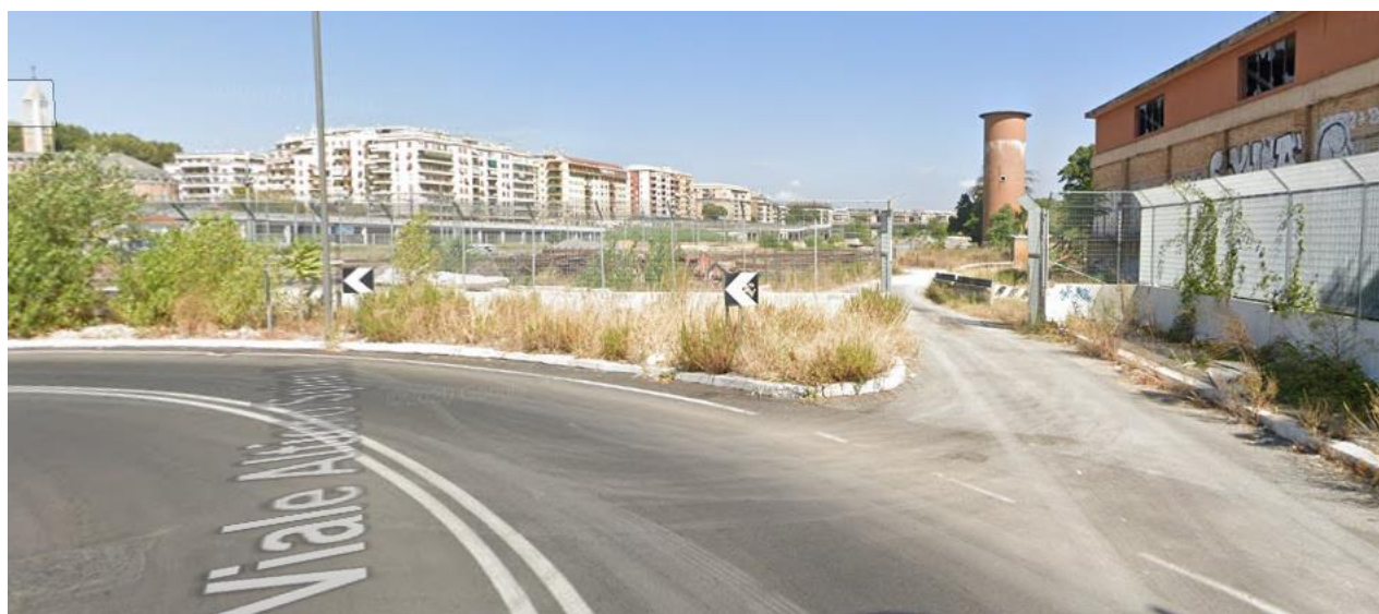
Foto accesso area FS da via Spinelli
