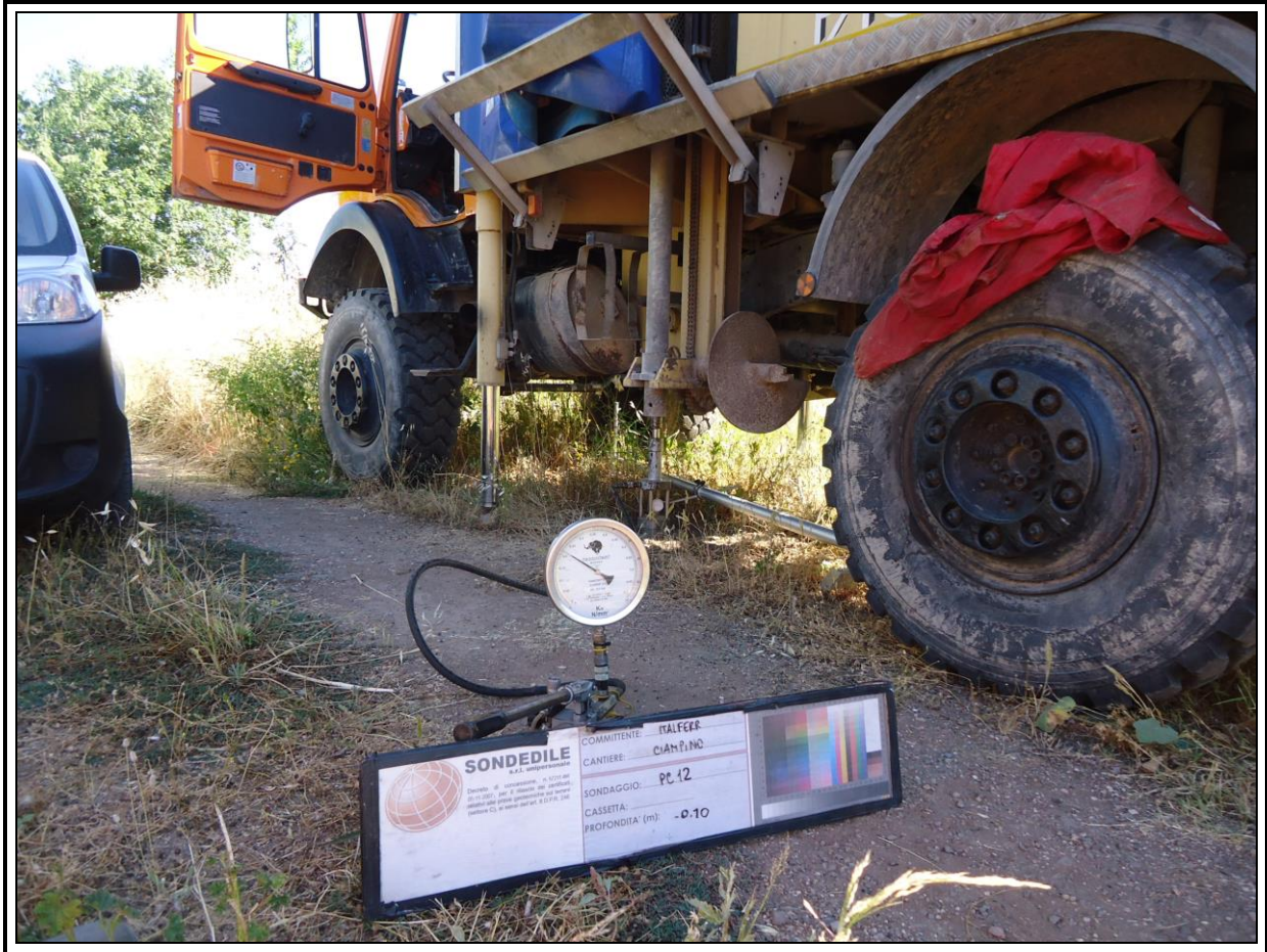
Figura 13 - Postazione prova di carico 12
