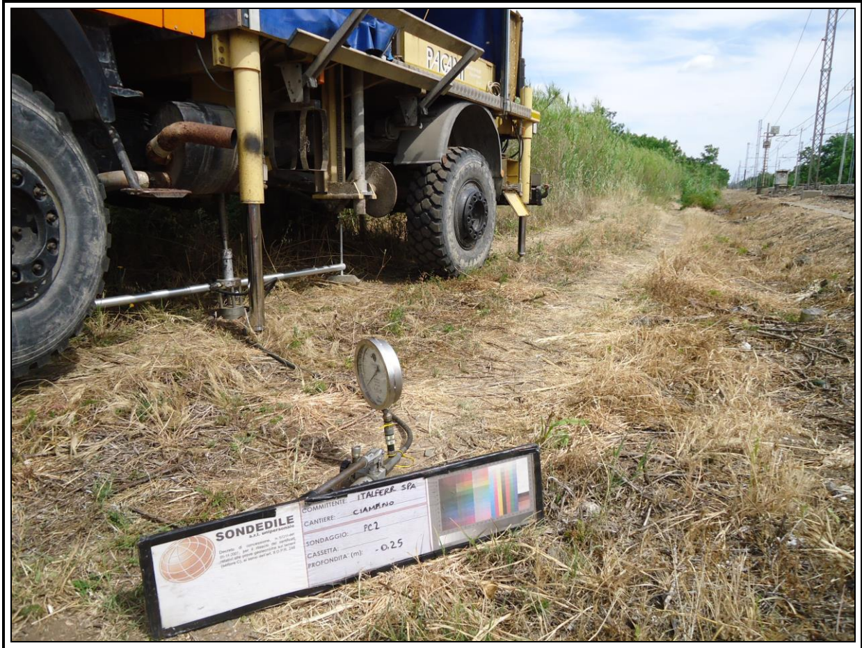
Figura 3 - Postazione prova di carico 2.
