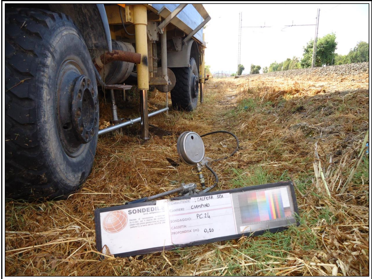
Figura 25 - Postazione prova di carico 24.
