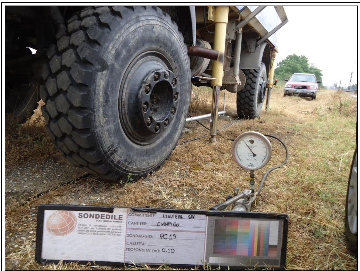
Figura 20 - Postazione prova di carico 19.
