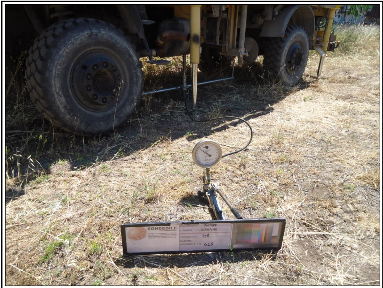
Figura 9 - Postazione prova di carico 8.
