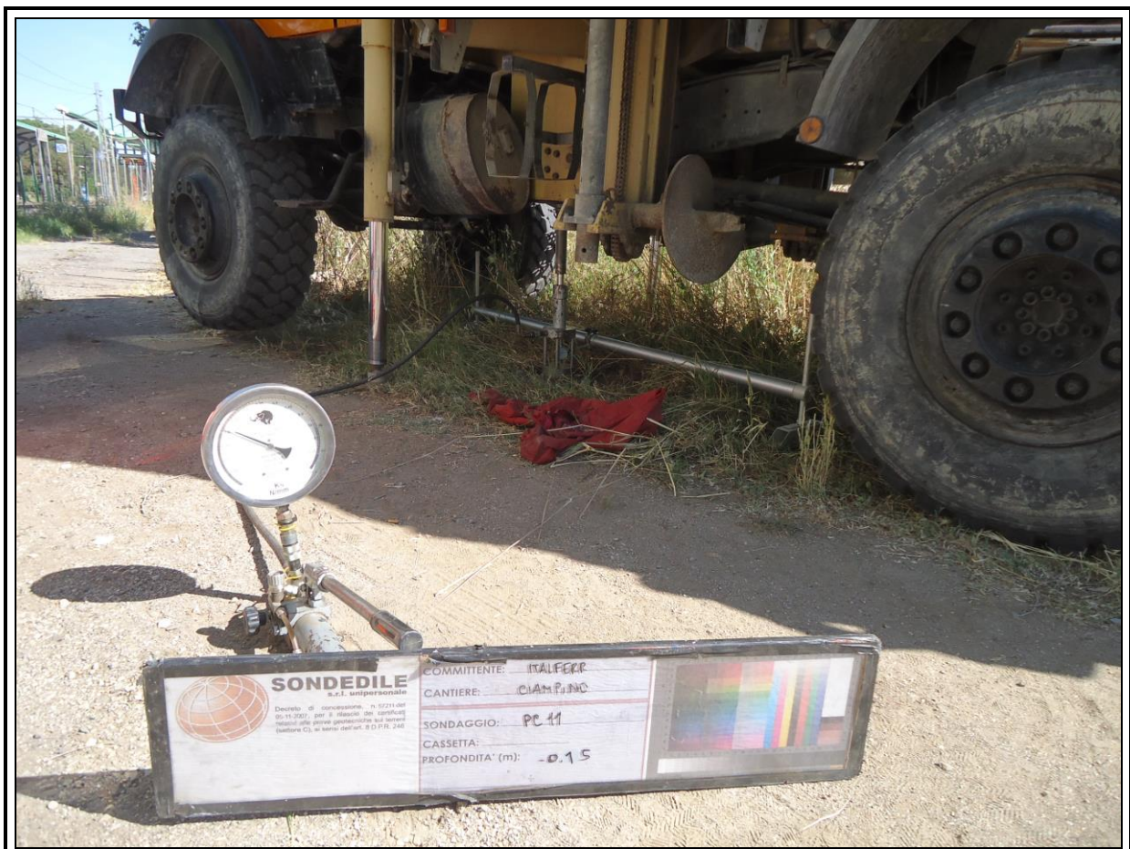
Figura 12 - Postazione prova di carico 11
