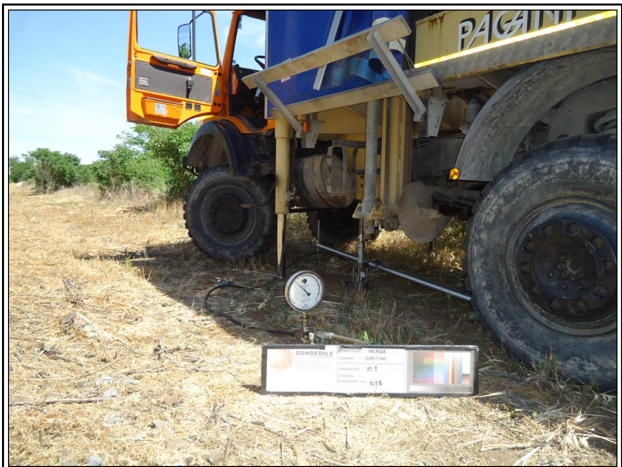
Figura 10 - Postazione prova di carico 9.
