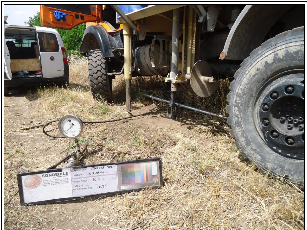
Figura 4 - Postazione prova di carico 3.
