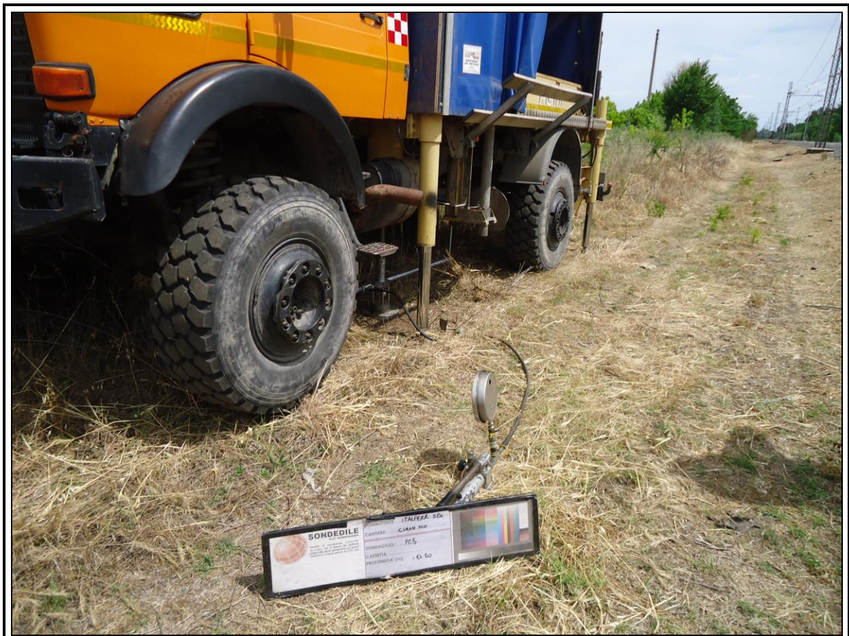
Figura 6 - Postazione prova di carico 5.
