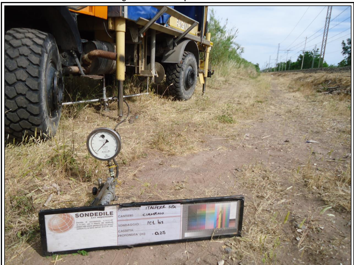
Figura 2 - Postazione prova di carico 1bis.
