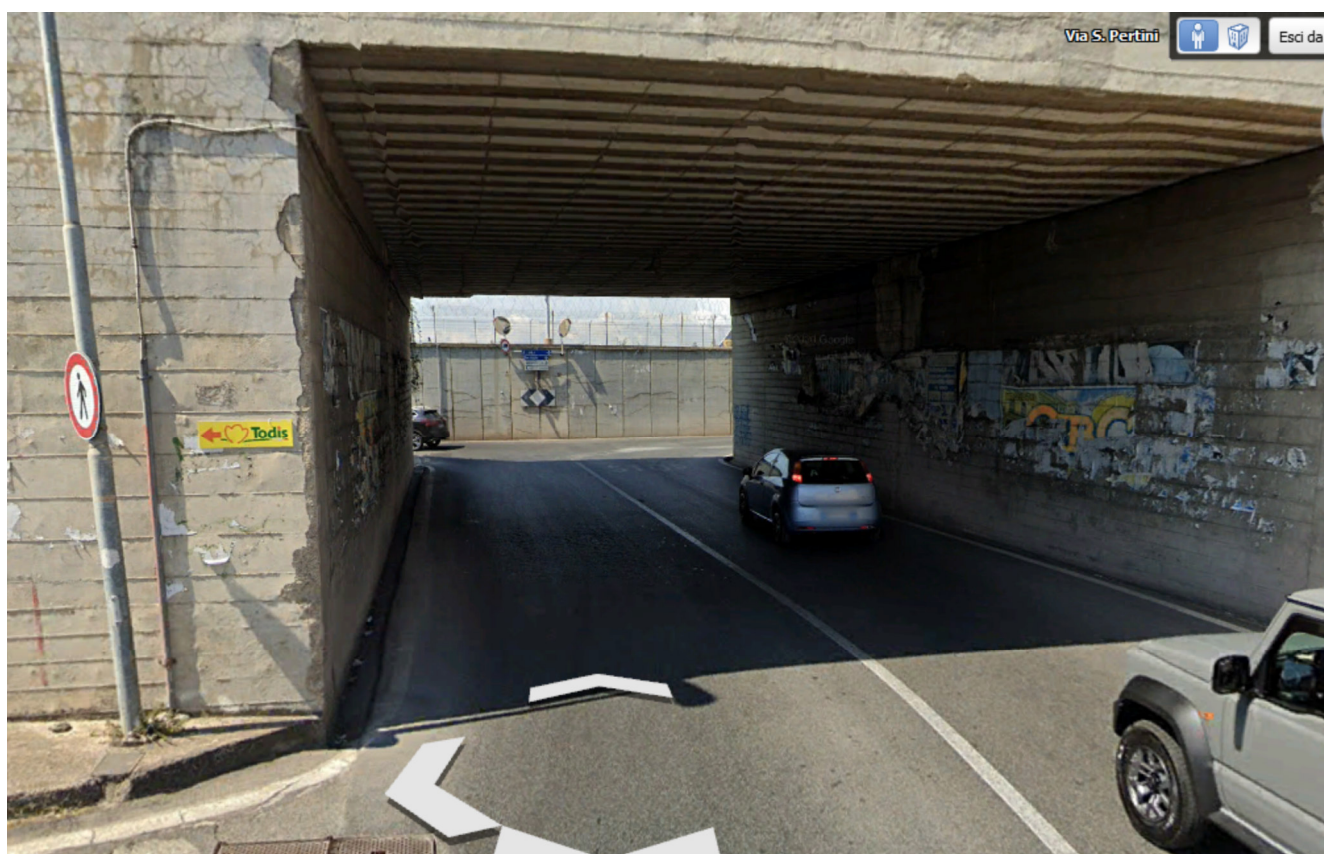
Figura 18 – sottovia esistente Via Sandro Pertini – imbocco lato via Donizetti
