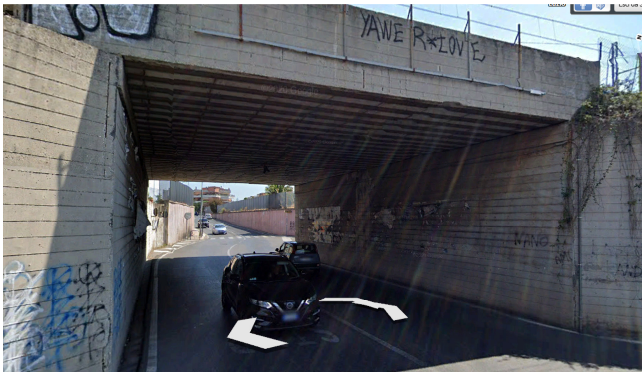
Figura 17 – sottovia esistente Via Sandro Pertini – imbocco lato via Folgarella
